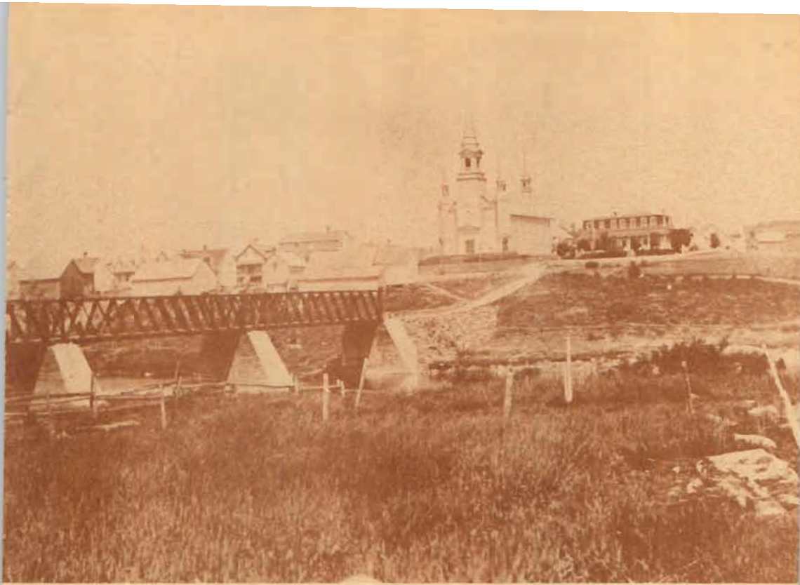
Le premier pont fait de bois construit sur la rivière Chaudière en 1901 (Photo fournie par Mme Jean-Marc Poulin)
