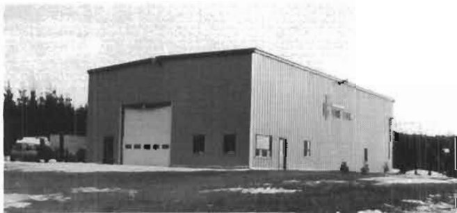
Usine construite en 1988 par Pierre Fluet
