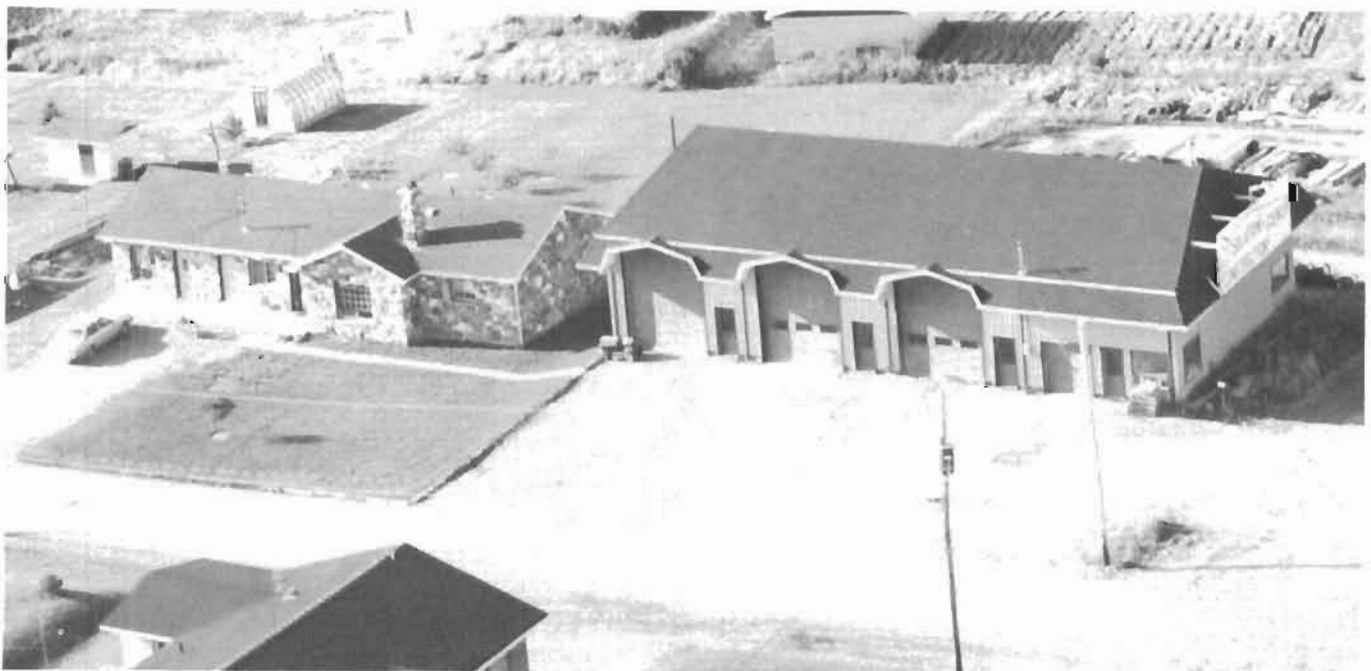
Dans la maison sont les bureaux des entreprises. À côté, les garages.
