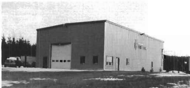
Usine construite en 1988 par Pierre Fluet
