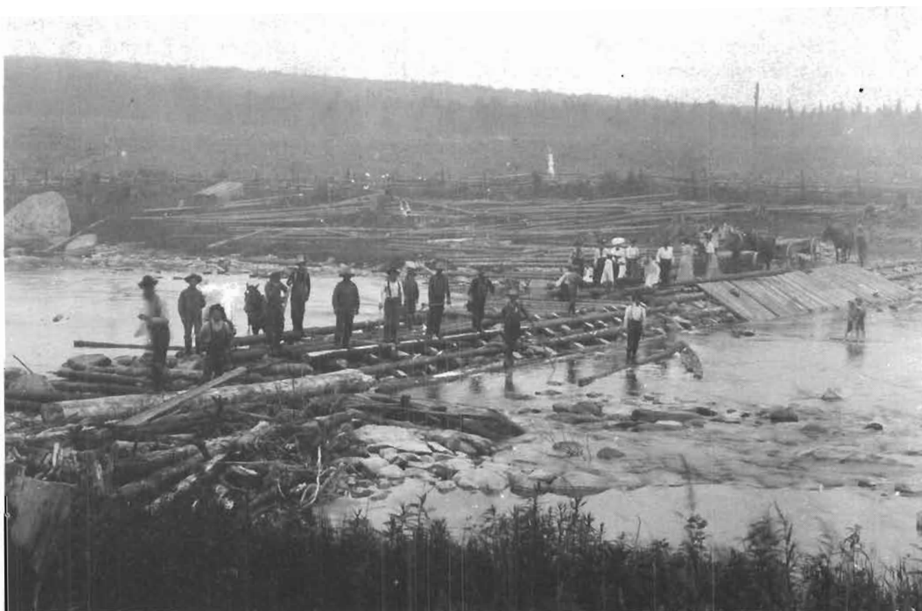
Construction de la dam
