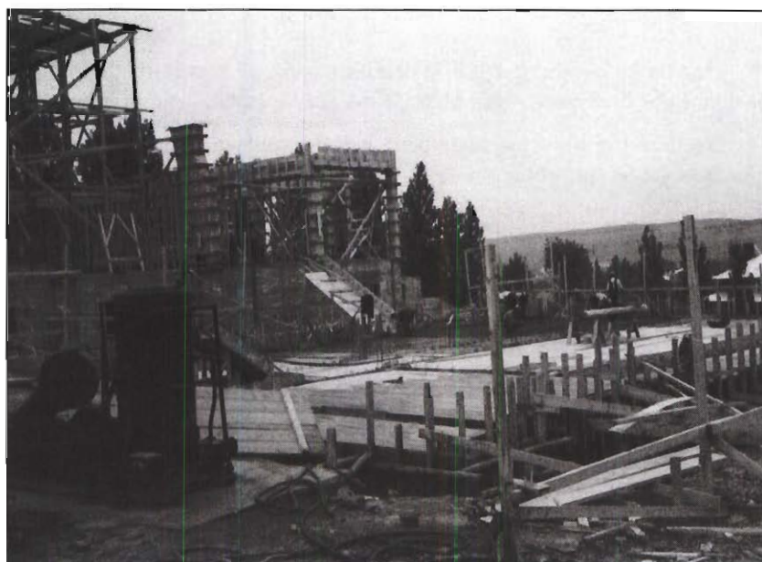
Les travaux au chantier de l'église ont débuté le 1 er mars 1951. La pierre est numérotée. On prépare le plancher du presbytère. 4 juillet 1951. (Fonds Fabrique de l'Assomption)
