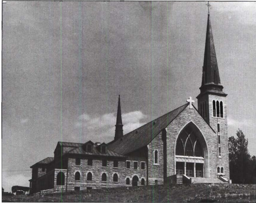
À gauche à l'arrière, des reliquats du chantier. La statue de la façade n'est pas encore mise en place. Le câble au clocher...
