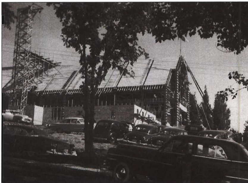
La toiture s'apprête à recevoir ses feuilles de cuivre. Photo prise de chez Henri Lacroix, sur les coteaux de l'Ardoise.
