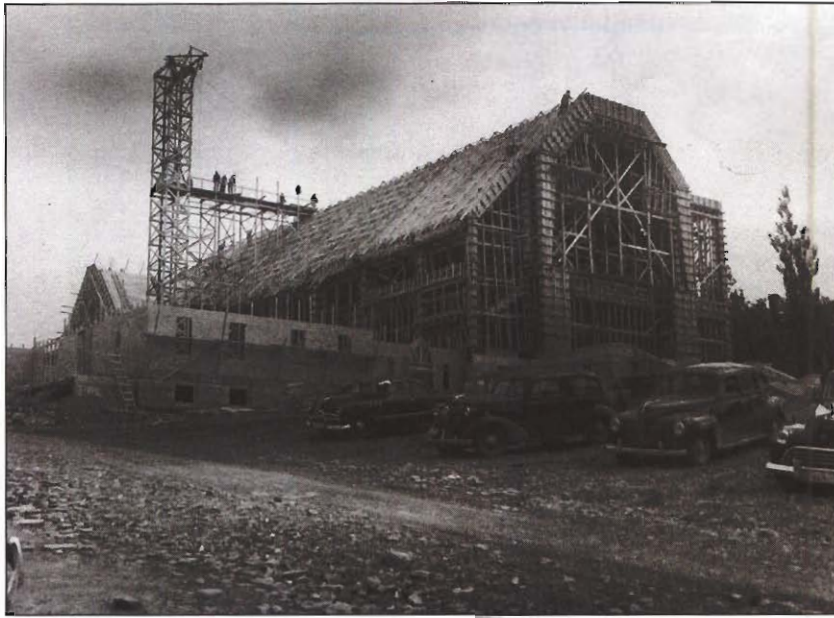
Le plafond de ciment de l'église coulé, des ouvriers préparent la toiture. Autos d'après-guerre. (Photo du journal L'Éclaireur, septembre 1951)
