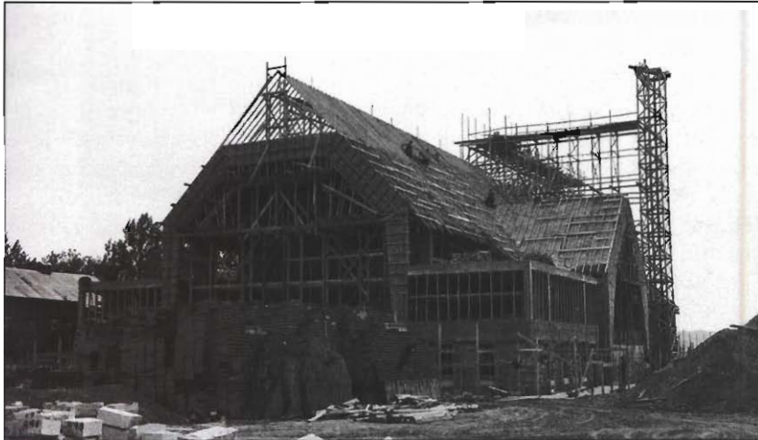
L'arrière du chantier. La charpente prend peu à peu forme. Automne 1951.
