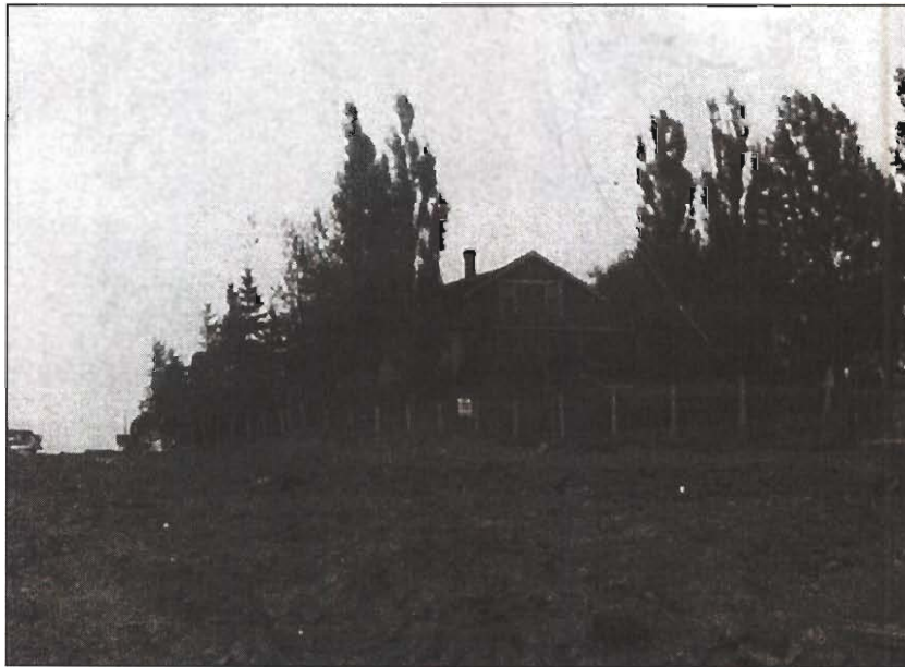
La Firme Edmond Morin nivelle le terrain de la Fabrique. Bientôt l'excavation de l'église. La terre de surplus comblera une partie du cimetière. Maison de Victor Rodrigue. Automne 1950. (Fonds Victor Rodrigue)
