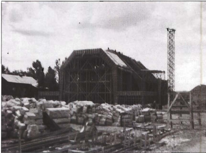
Voûtes et toiture coulées, les pierres attendent les tailleurs et les maçons sur le stationnement arrière.
