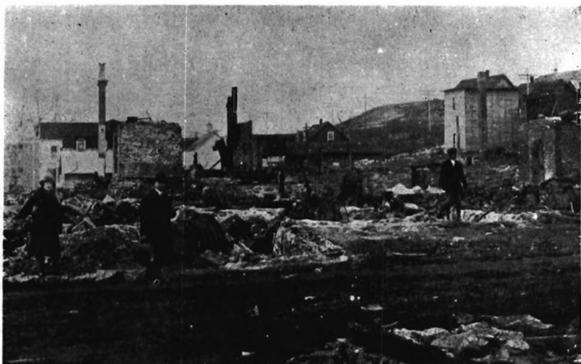
Le 21 novembre 1915, plus de cinquante maisons de St-Georges-Est furent détruites par une grande conflagration qui ruina aussi plusieurs dépendances. On voyait des scènes désolantes comme celle-ci dans la moitié du village.
