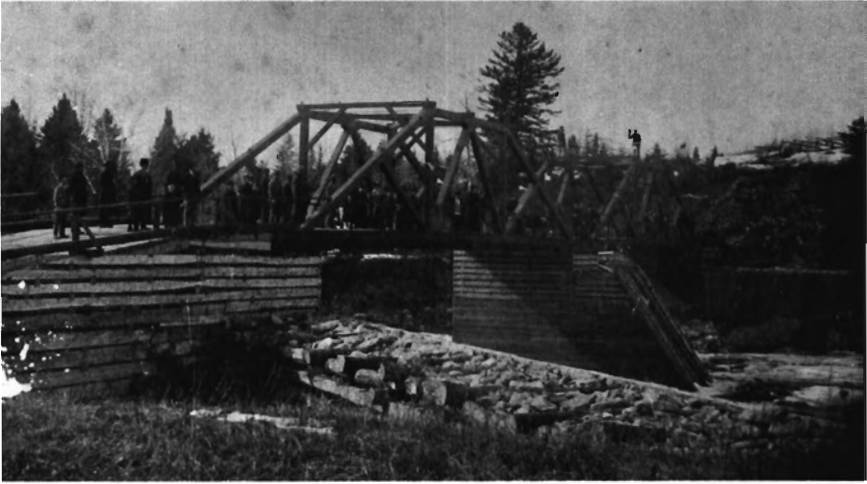
Ce pont de bois sur la rivière Du Loup fut construit en 1897 par Louis Gendreau. On le remplaça en 1909 à la suite des représentations faites par le député Arthur Godbout.
