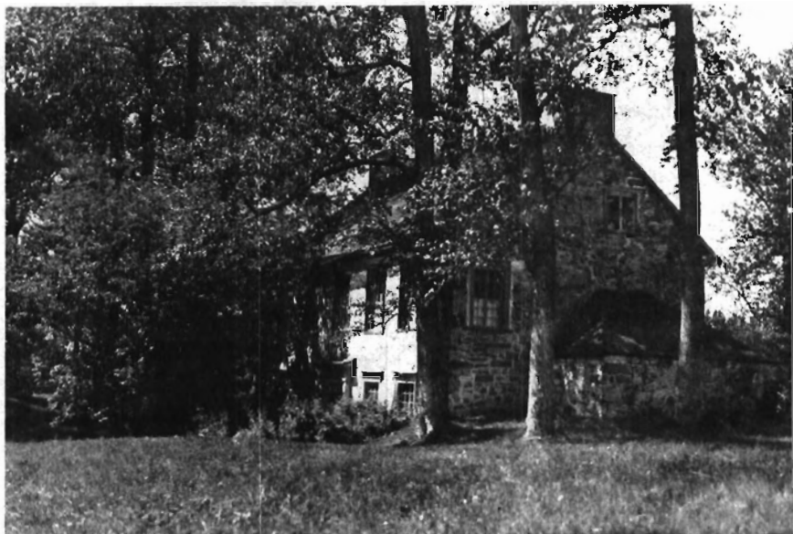
Le premier manoir Taylor construit en 1840; il fut remplacé en 1917 par la résidence actuelle des demoiselles Taylor à Cumberland.
