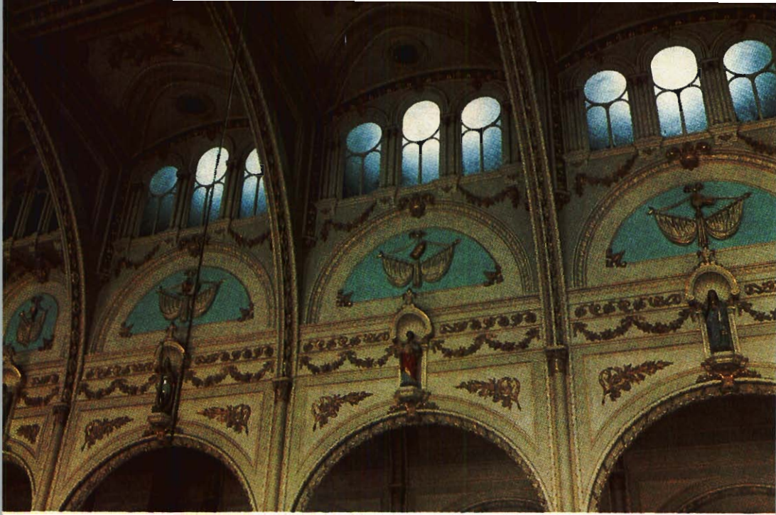
La voûte et les statues.
