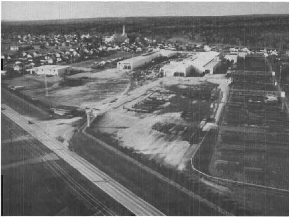
Les installations des Aciers Canam à l'automne 1989.
