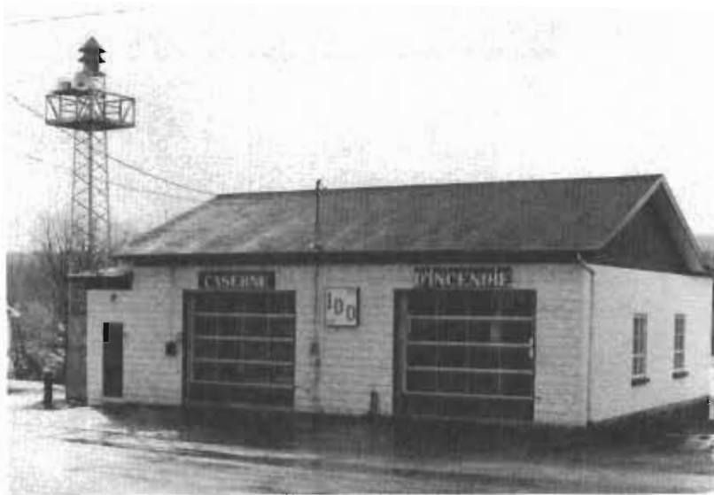
La caserne d'incendie.
