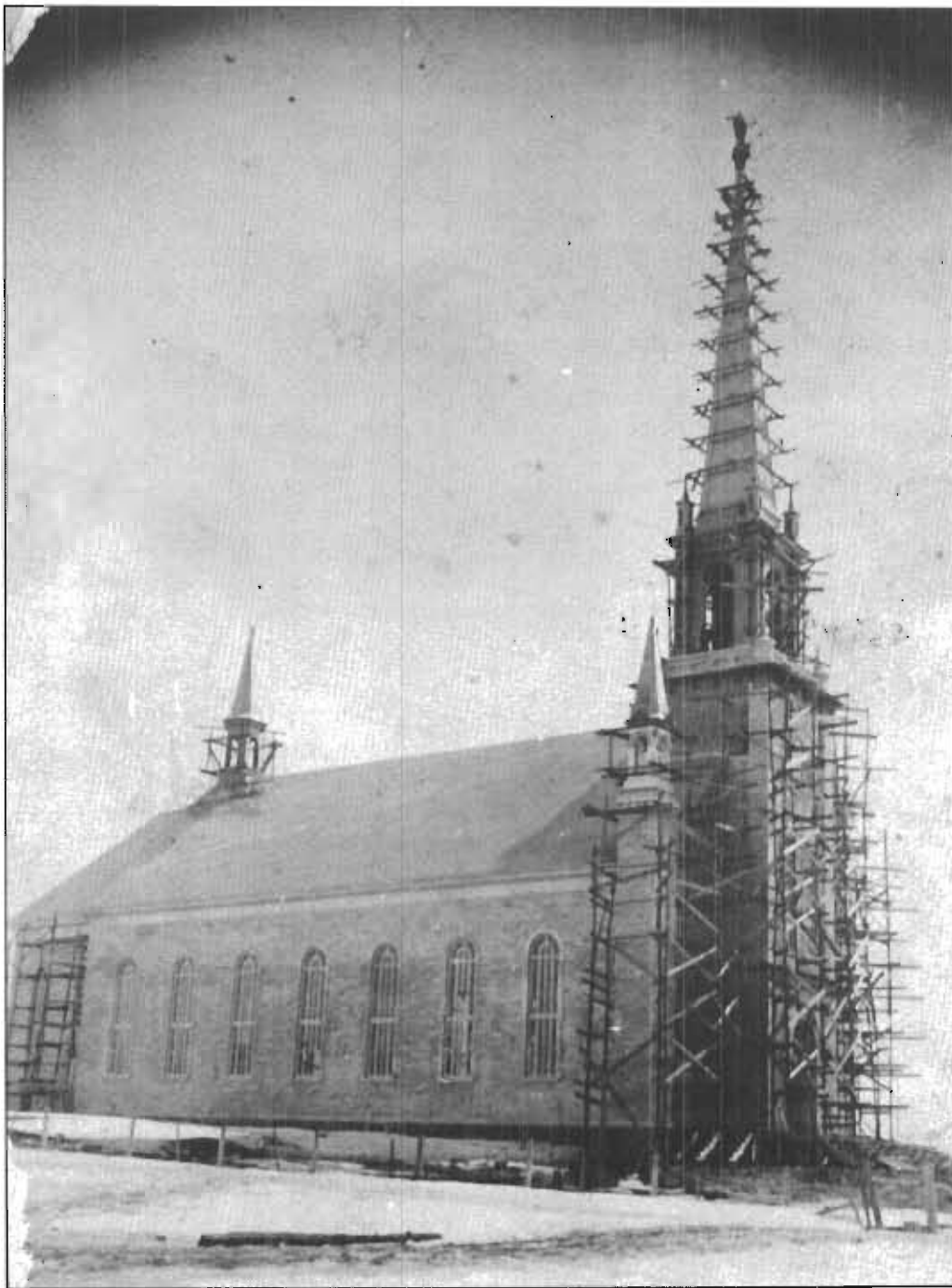
Notre église en construction ou lorsque la pierre s'assemble et devient temple.
