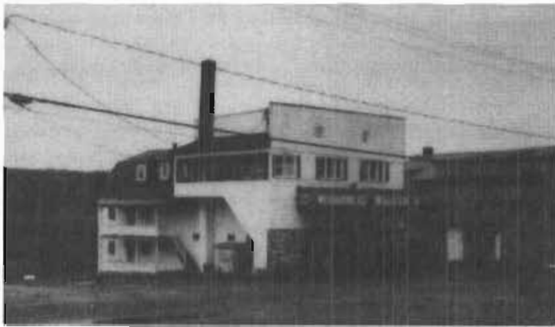
Édifice ayant abrité le Théâtre Frontenac. Photo prise avant les rénovations de 1988.
