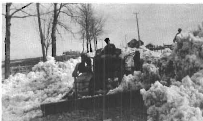
Ouverture de la route du rang 7.
