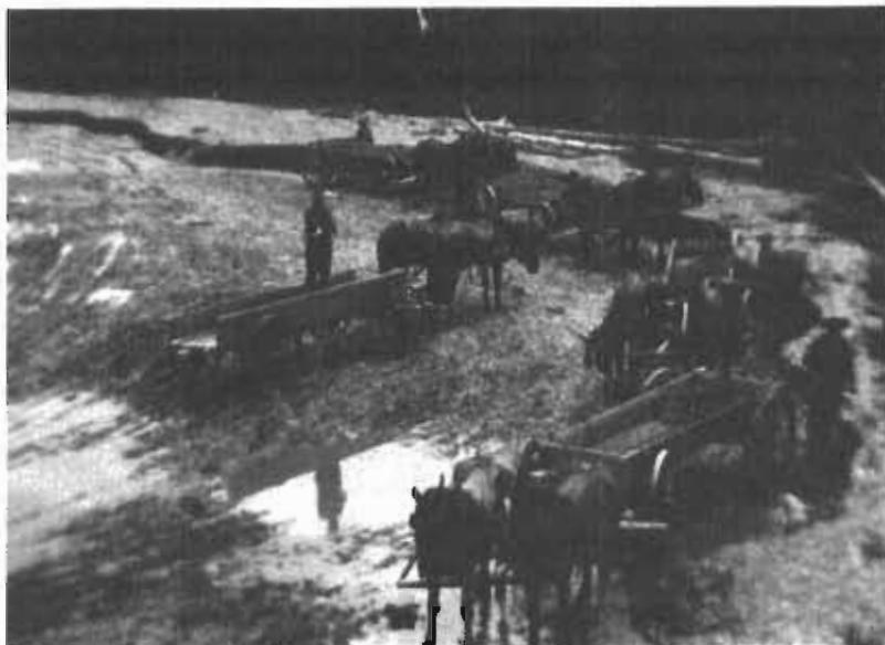
Construction d'une route.
