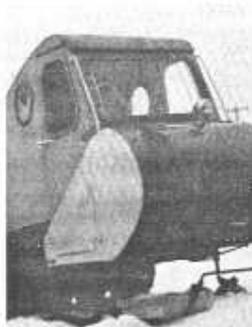
M. Poulin conçut à la fin des années 1950 ce petit auto-neige muni d'un moteur de scie-mécanique Mercury bicylinde de 11 HP. Cet engin pouvait atteindre 28 mph
