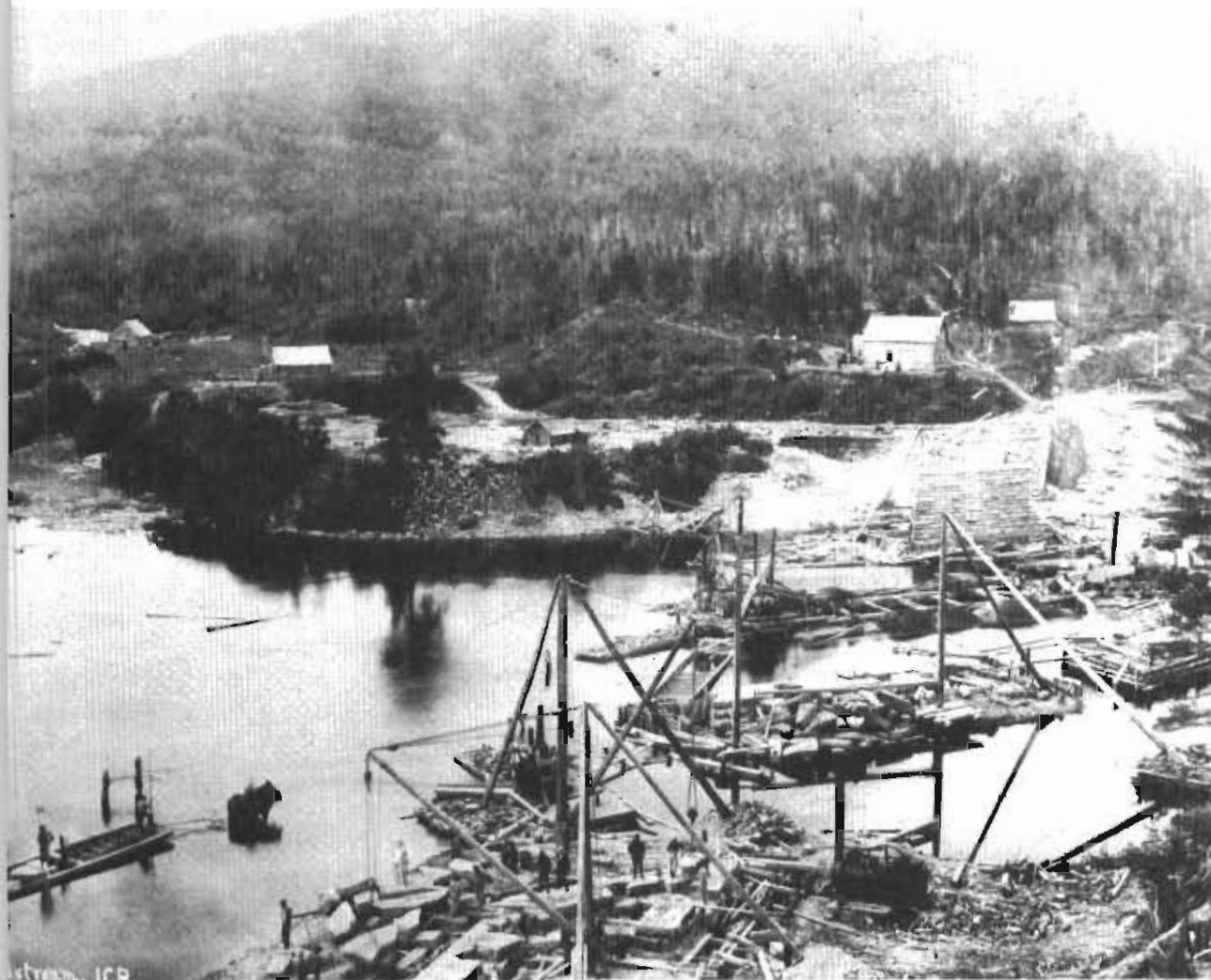
Construction d'un pont de l'Intercolonial à Millstream vers 1870. (APC)
