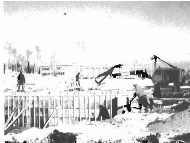
Construction du Centre d'achat
