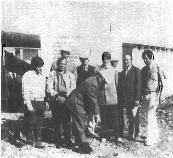
Pelletée de terre - Centre communautaire Phase II
