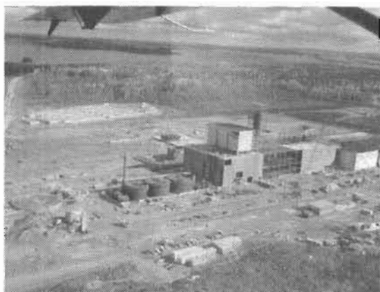
Vue aérienne de la construction de l'usine
