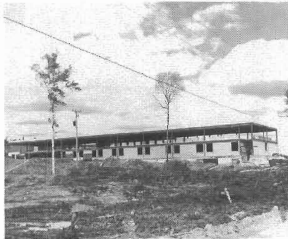
Construction de l'école Boréale
