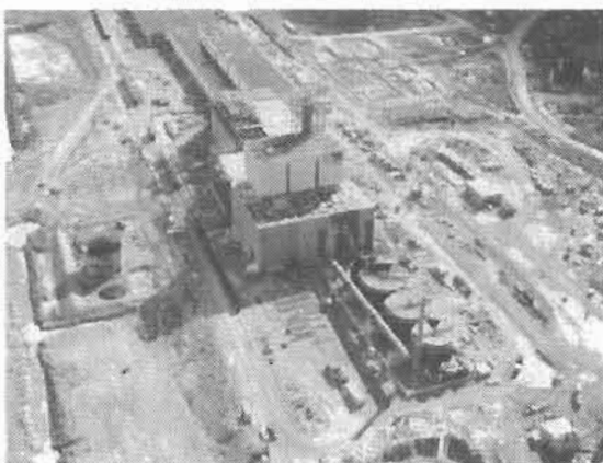
Vue aérienne de la construction de l'usine
