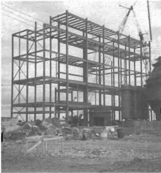
Juillet - Construction de l'usine.
