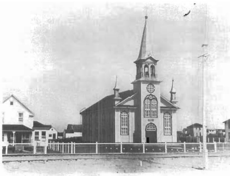
Église St. Joseph construite en 1918
