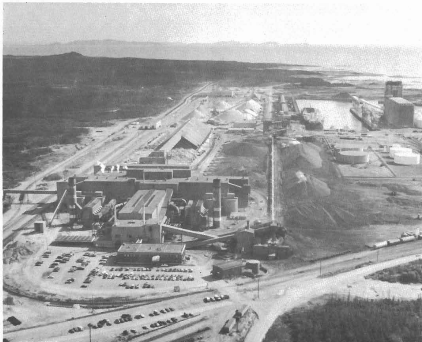
L'usine de bouletage où on transforme le minerai en boulettes concentrées afin de faciliter son transport. Source : archives de la compagnie minière Québec Cartier.
