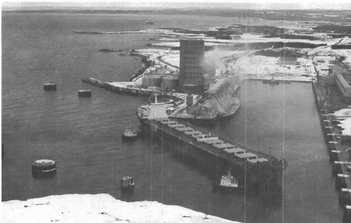
Le port industriel de Port-Cartier peut accueillir des navires de plus de 200 000 tonnes. On aperçoit, sur la pointe, les silos à grains. Source : archives de la compagnie minière Québec Cartier.
