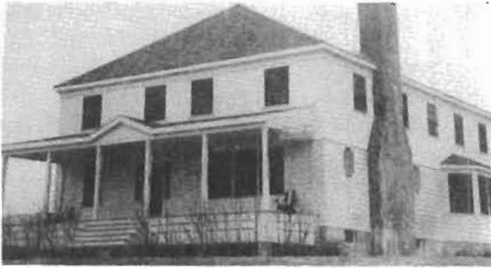
Parent Lodge, la maison du personnel de la compagnie à Shelter Bay. Elle fut inaugurée en 1938. Cette photo a été prise à la mi-juin, avant que les plantes et les arbustes aient fleuri.
