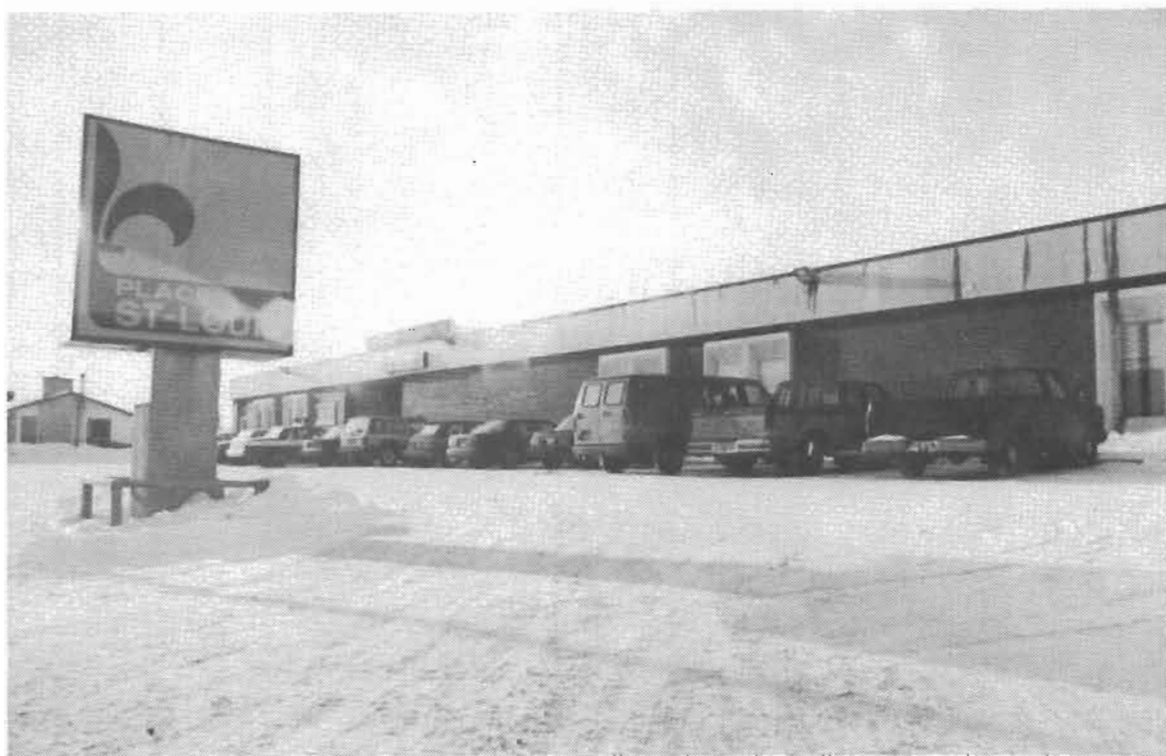
Place Saint-Louis, un autre centre commercial du quartier ouest.
