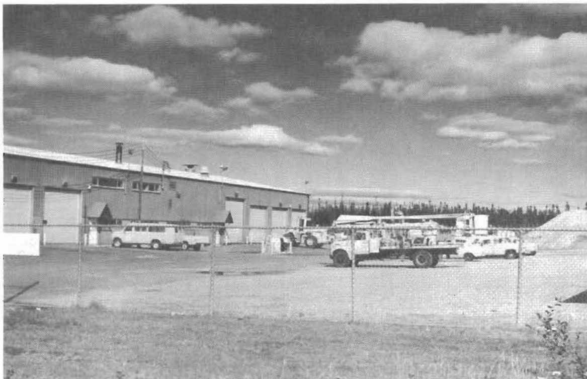
Bâtiment de service de la voirie.
