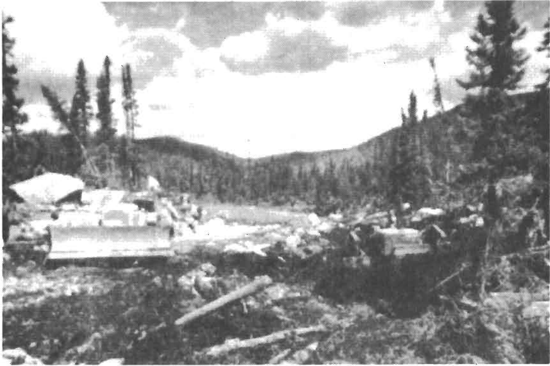
En 1953, deux bulldozers travaillent ensemble sur la nouvelle section de la route de la rivière de la Petite Coulevre, à Shelter Bay.
