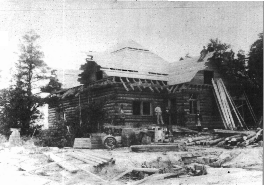
Le Château Brown de l'Île du Collège en construction en 1894. (Archives Société d'Histoire du Témiscamingue)
