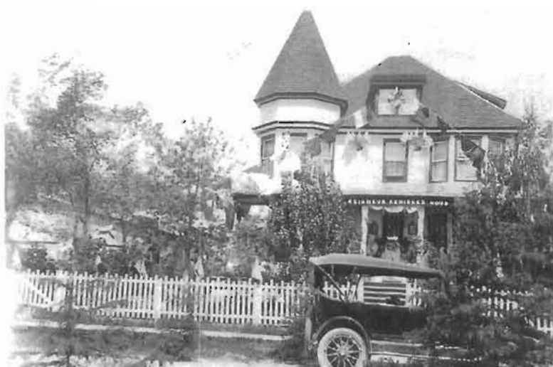
Une maison cossue de la rue Notre-Dame Nord, à Ville-Marie, vers 1918. (Non classée, Source: Guy Chénier).
