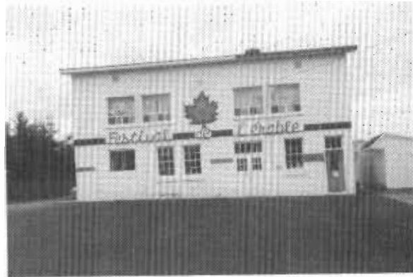
Cet édifice municipal regroupe les services suivants: en bas à gauche, le bureau municipal, au centre, l'atelier de l'inspecteur municipal, en haut en avant, la bibliothèque municipale et à l'arrière, l'atelier des tisserandes.
