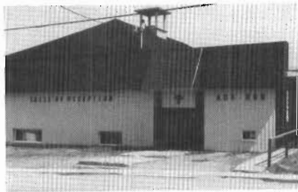
La Salle municipale, rénovée en 1988.
