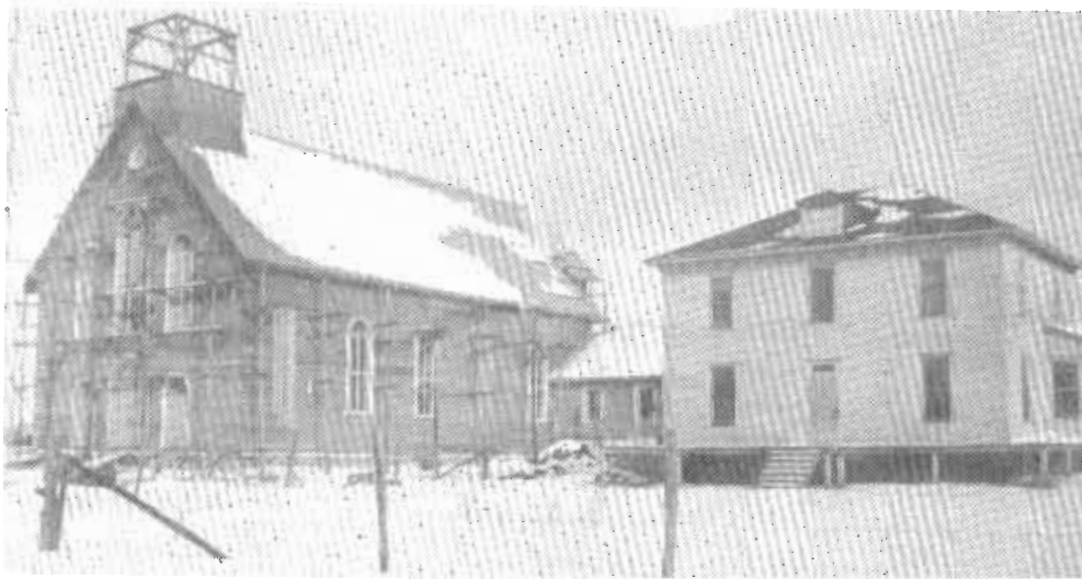
Le presbytère et l'église en construction en 1912.
