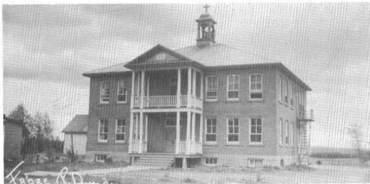
Couvent des Soeurs de l'Assomption, érigé en 1938 et démoli en 1974.
