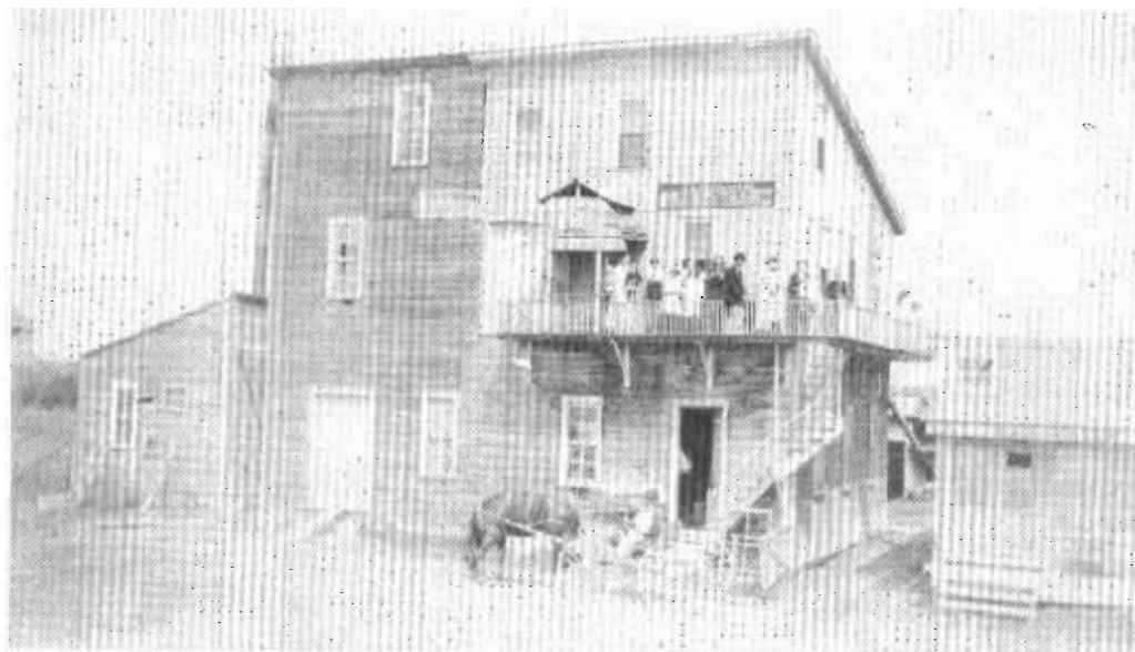
Manufacture de portes et fenêtres ayant appartenu à Delphis Déselliers, qui l'a vendue par la suite à Méric Lapierre (fils).
