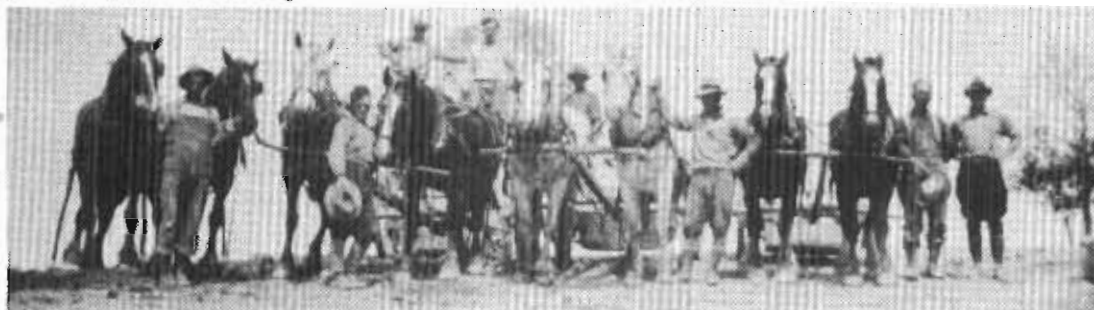
Avant l'arrivée des machineries lourdes, Jos Barbe, Henry Bourgeois et Oeila Barbe coupent les buttes de terre du village, en allant vers Ville-Marie, avec des "scrapers".
