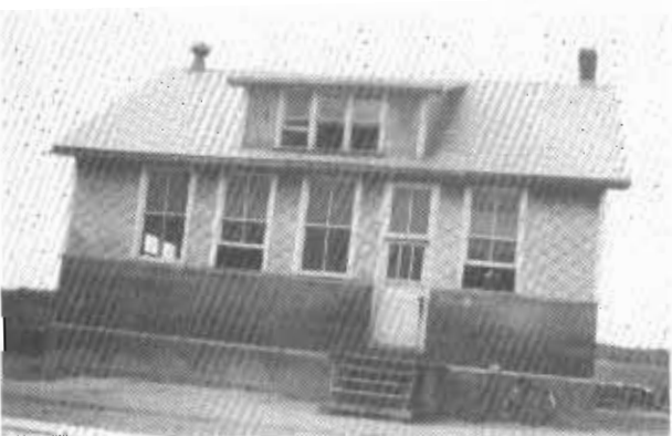
L'école no 3 à Fabre Station.
