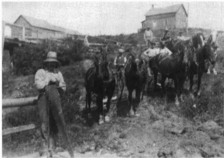
Réparation du chemin pour la construction du pont dans les Côtes à Perreault, sur le lot 52, rang 5. Conducteur des travaux, Joseph E. Lanouette, tenant le godendart
