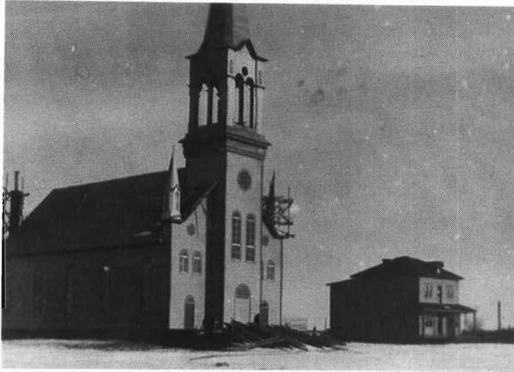
La construction de l'église tire à sa fin
