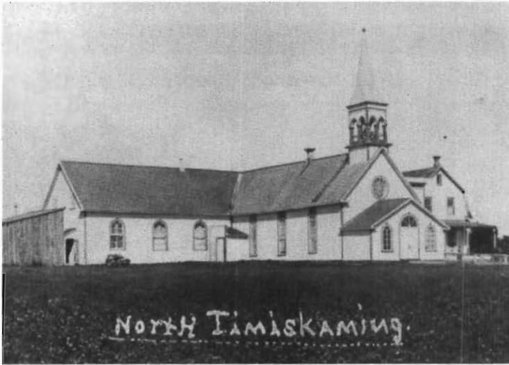
La chapelle de Notre-Dame-du-Nord, après rénovation
