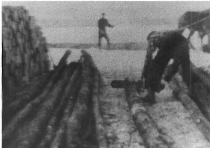
La tronçonneuse accélère les travaux
