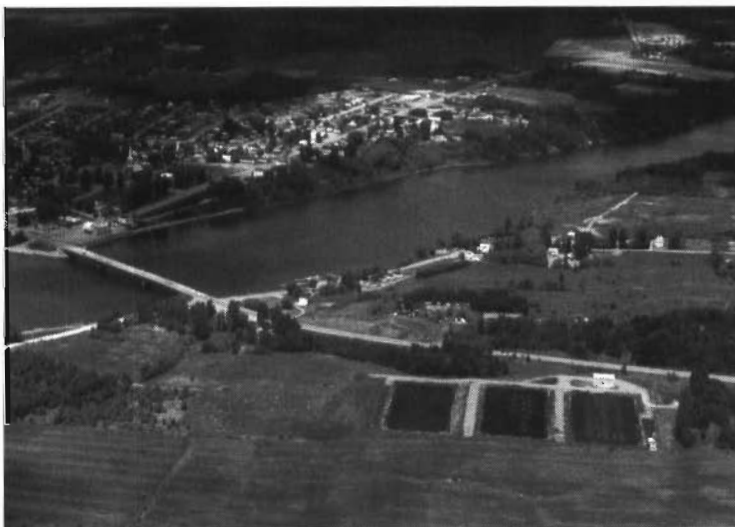
Les bassins pour le traitement des eaux usées. (Photo A. Prévost)
