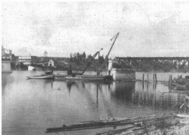
Construction du pont
