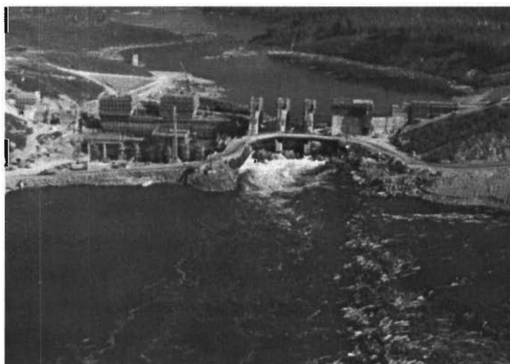
La Centrale Première-Chute. (Photo A. Loiselle)
