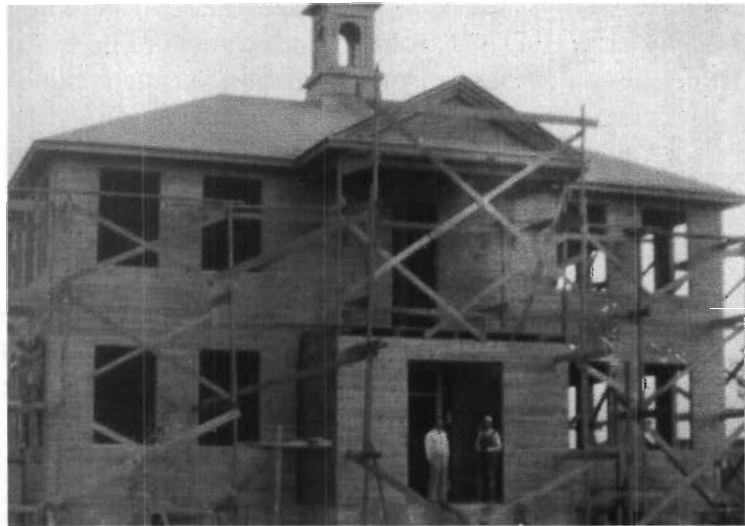
La construction du couvent. (Photo Beauséjour)
