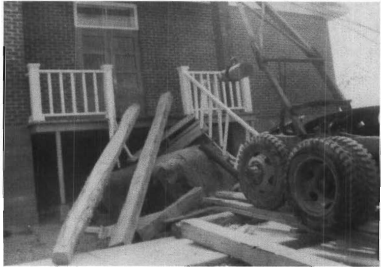
Durant l'année 1953-1954, le Collège loge la Caisse populaire. Lorsqu'on y entra le coffre-fort tout neuf, la galerie s'est effondrée et le coffre s'est retrouvé par terre
