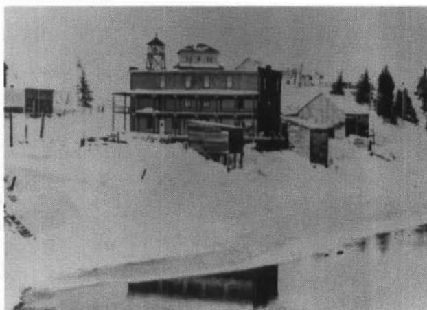
Hôtel de Constant Delhalle qui a brûlé au Grand feu de 1922; en face de l'hôtel, le central téléphonique
