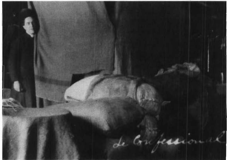
Le curé Moreau, confesseur au chantier
