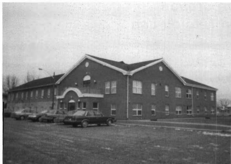
Pavillon après la nouvelle construction, en 1993
