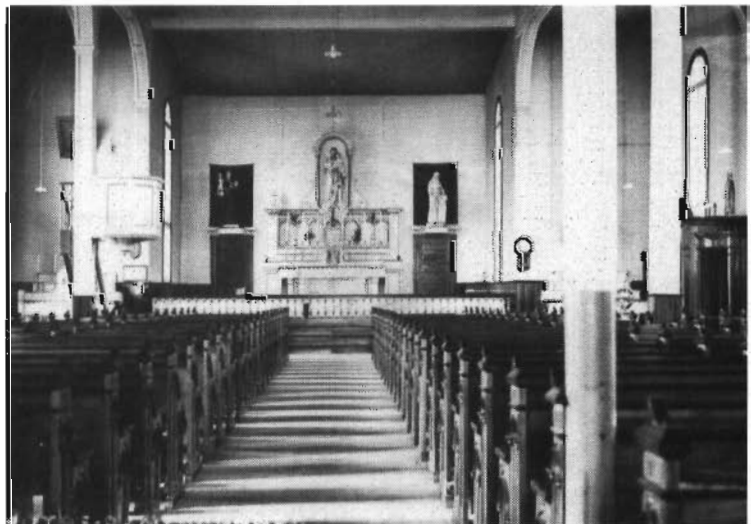
L'intérieur de l'église, entre 1936 et 1940
