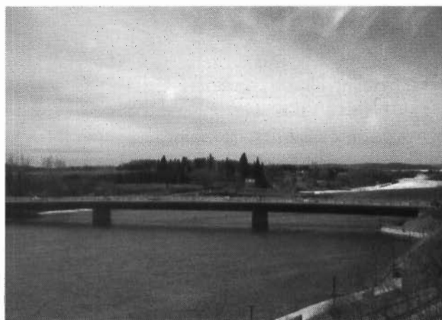
Le pont construit en 1971
