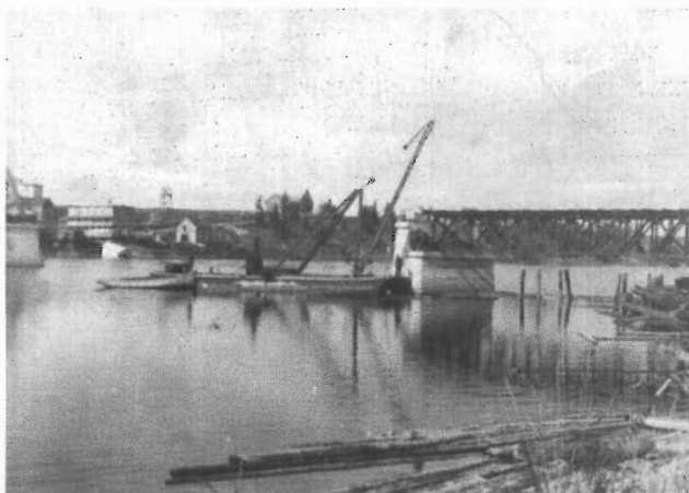
Construction du pont
