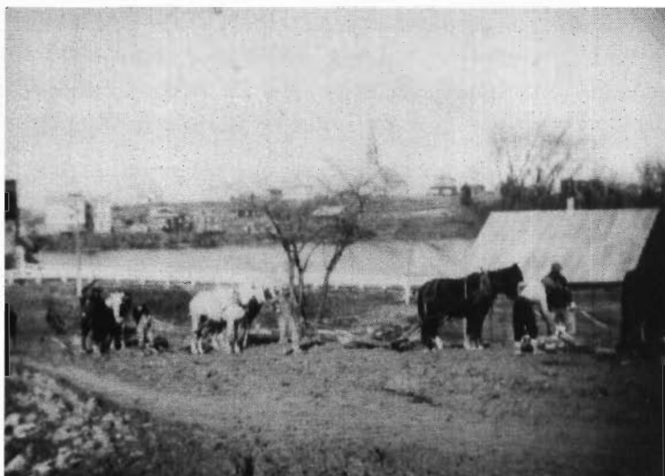
Construction du "Chemin neuf", par le contracteur Alfred Larouche. Ce chemin permettait de filer tout droit vers Ville-Marie, en sortant du pont. (Photo Beauséjour)
