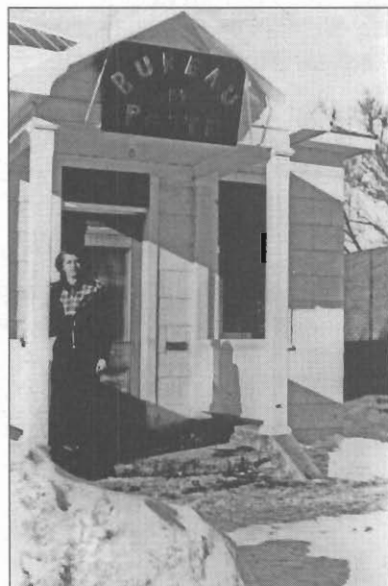
Bureau de poste chez Adalbert Lepage
