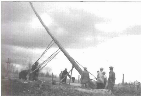
Érection des poteaux de la ligne électrique, partie campagne, en 1947
