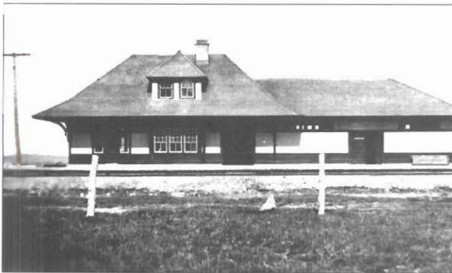
La gare de Lorrainville
