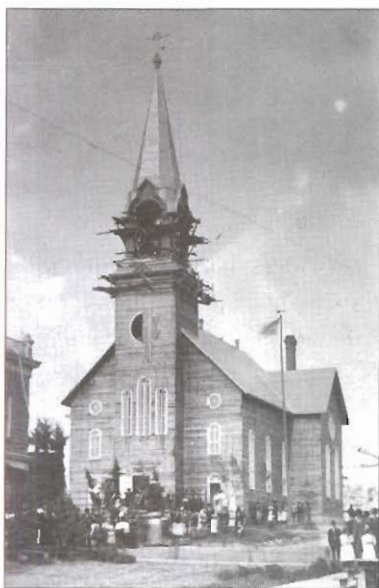
Église en construction, vers 1909 Source : Aline Vaillant
