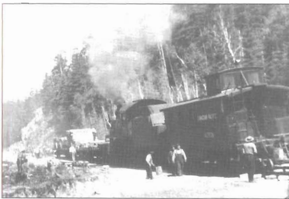
Construction du chemin de fer Témiscamingue-Angliers vers 1922-1923
