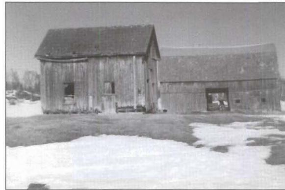
Maison en bois de planches (bois scié) sur la ferme de Maxime Rocheleau au rang St-Jean
