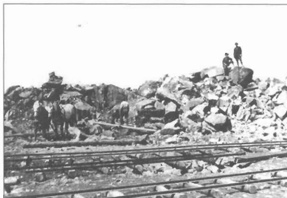
Construction de la voie ferrée
