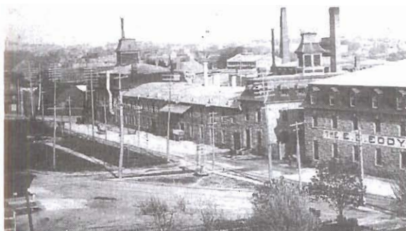
Usine E.B. Eddy, Hull vers 1871
