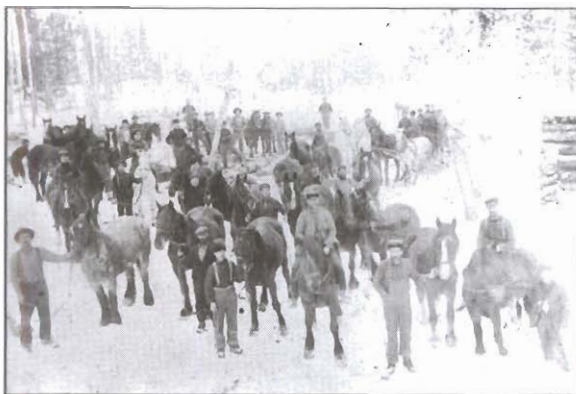
Chantier chez Clovis Baril, vers 1900
