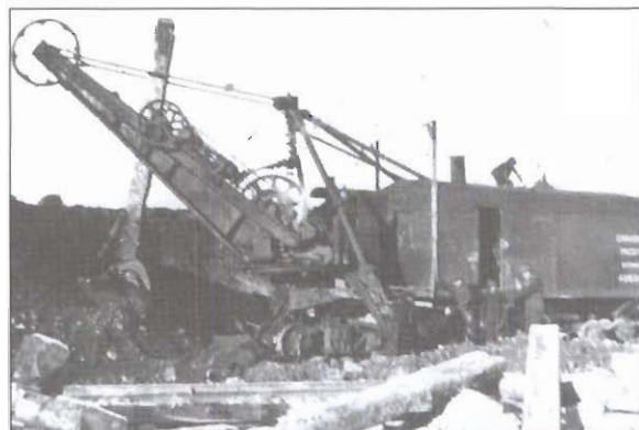
Construction du chemin de fer
