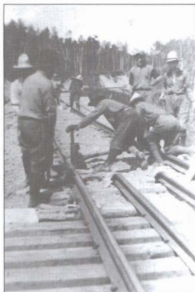
Construction du chemin de fer
