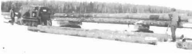
*L'assemblage d'un «boom» pour transporter les billots*
