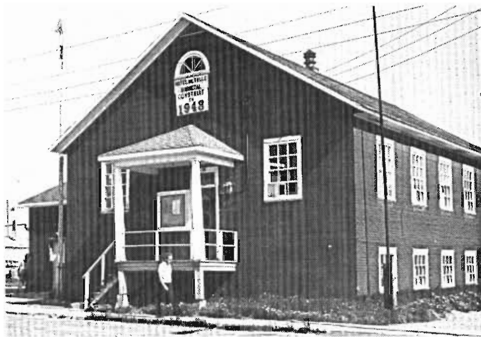
Hôtel de ville de Normétal avant sa rénovation
