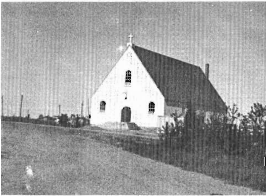
Construction de l'église, avril 1943
