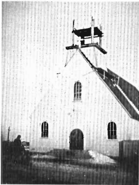
Photo du haut: Inauguration officielle de l'église - 1943 Photo du bas : Construction du clocher - 1946
