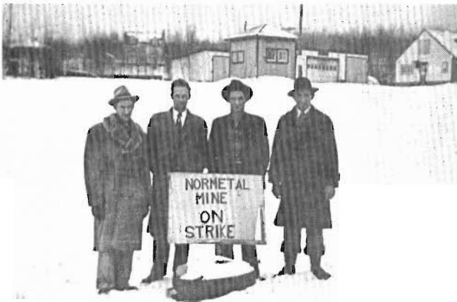
Travailleurs de la mine Normétal lors de la grève. Octobre 1953 à février 1954.
