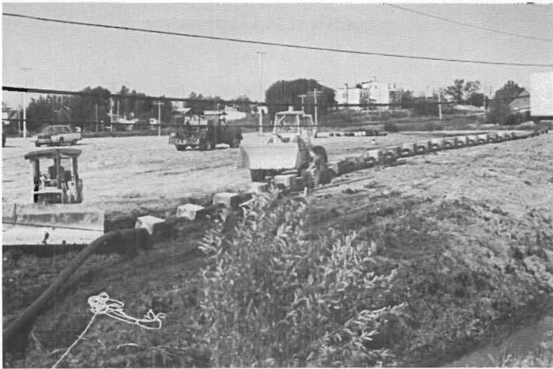
Travaux d'aqueduc en 1989
