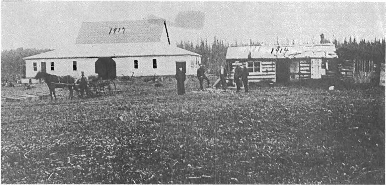
En 1917, dans le 2 e Rang du canton Royal-Rousillon, à Macamic. À droite, le premier camp en bois rond, construit en 1914, et à gauche, l'immeuble construit en 1917. Nous remarquons près du cheval, monsieur Elphège Boisclair, puis, en groupe, le prêtre-colonisateur Ivanhoé Caron, Z. Bazin, mademoiselle Emma Boisclair, ainsi que deux officiers du ministère de la Colonisation.
