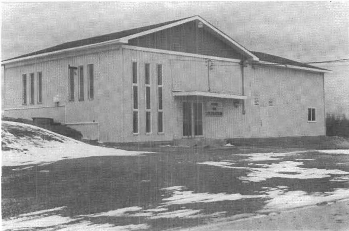
L'usine de filtration actuelle
