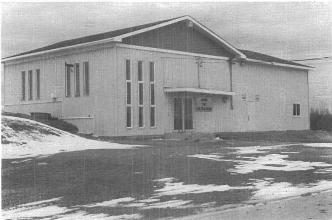
L'usine de filtration actuelle
