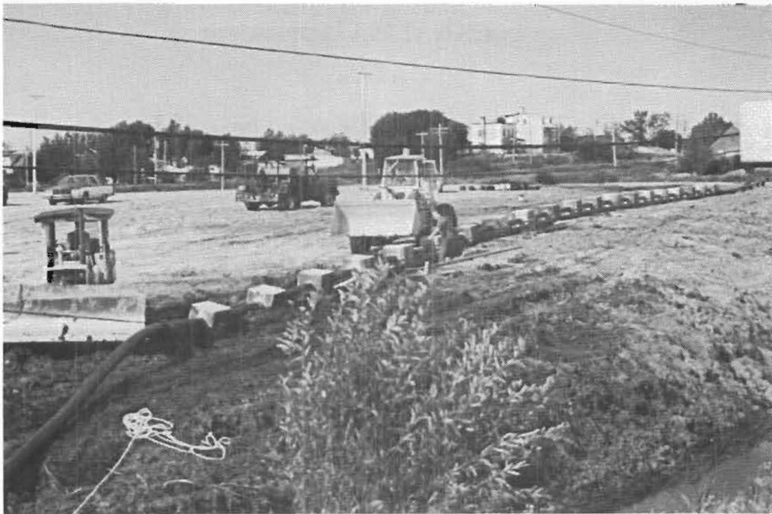
Travaux d'aqueduc en 1989
