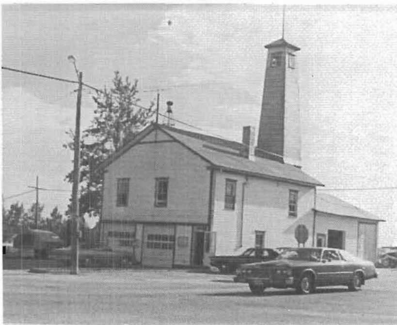
Construit en 1927 et détruit en 1974, cet édifice contenait la caserne des pompiers, la salle du conseil ainsi que le logement de la famille Luc Lachaine.
