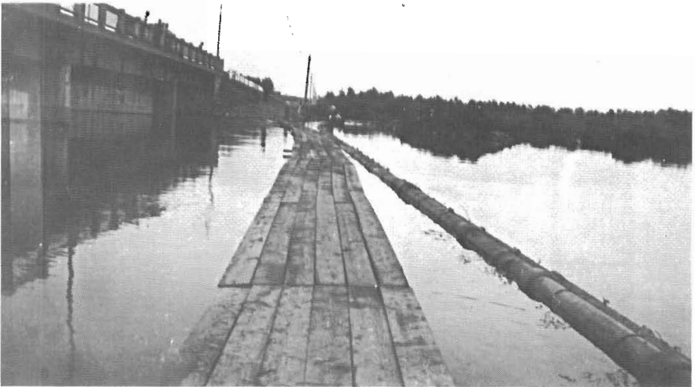
Travaux d'aqueduc en 1950 première canalisation d'alimentation en eau potable au Centre hospitalier Saint-Jean
