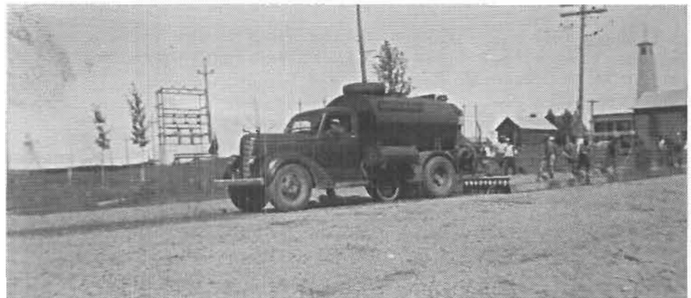
Pavage de la rue Principale
