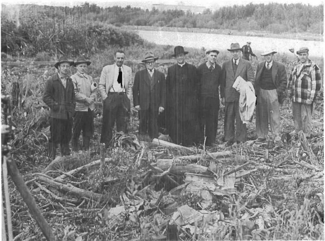
Construction de l'aqueduc en 1950
