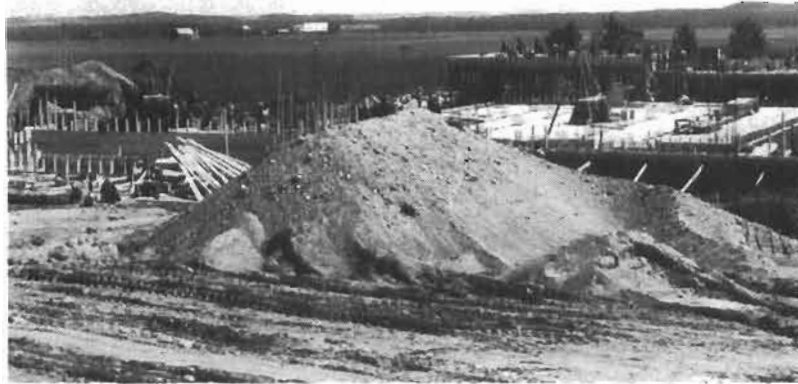
Début de la construction de l'hôpital St-François d'Assise de La Sarre.
