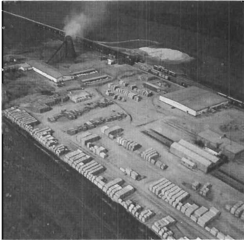
Usine de sciage, rabotage et séchoirs J.H. Normick Inc.
