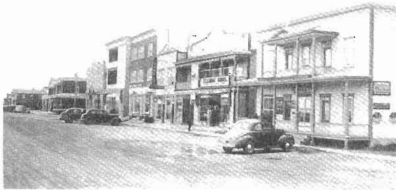
Partie nord-ouest de la rue Principale.
