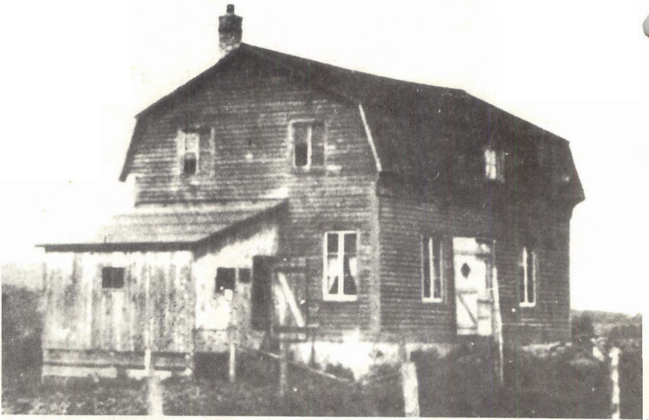
La maison construite par Timothée Bisson en 1920.
