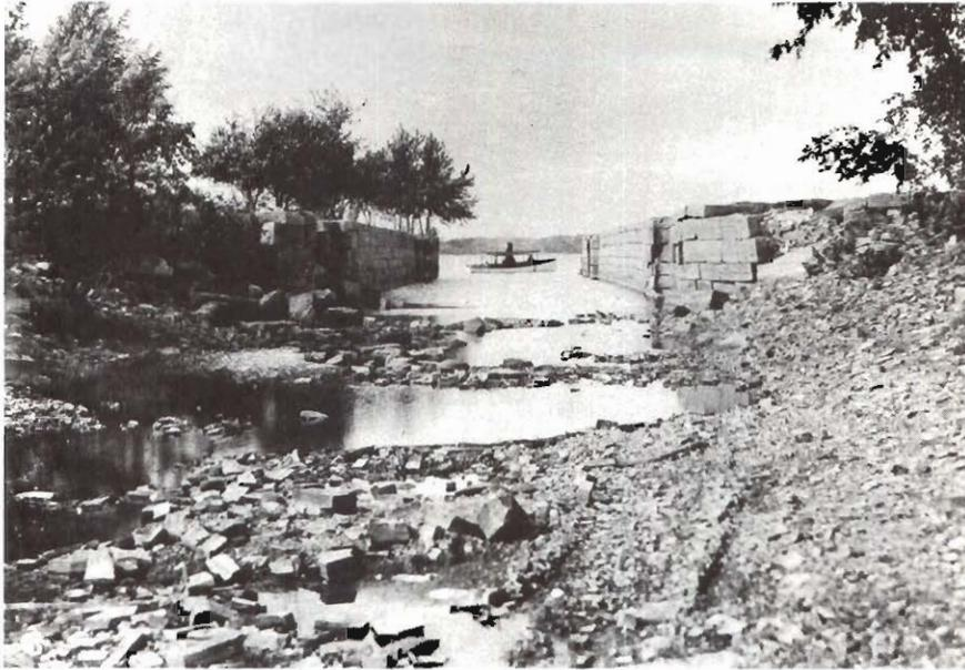
**Figure 11** Ruines de l'écluse n° 3 du vieux canal militaire de Carillon en 1909. La construction du barrage hydro-électrique de Carillon en 1963, a complètement submergé cette écluse ainsi que toute la section du premier canal, située en amont de l'écluse actuelle à Carillon.
