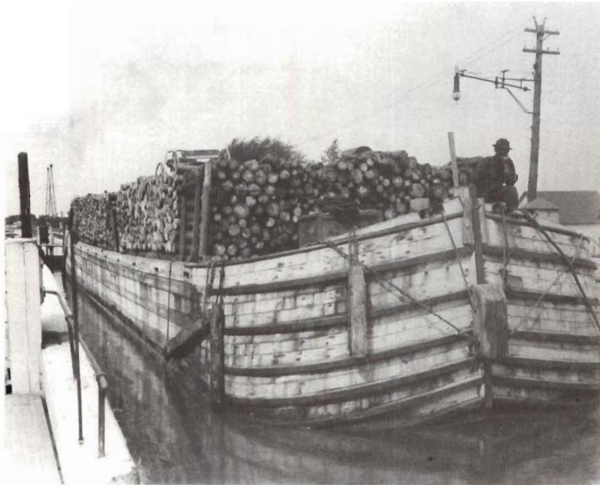
**Figure 22** Une barge, type d'embarcation le plus populaire utilisé pour le transport des marchandises sur les canaux de la rivière des Outaouais, entre 1834 et au-delà des années 1940. Ce type de barge était également utilisé sur d'autres canaux provinciaux tels, le canal Chambly et l'écluse Saint-Ours. (Archives publiques Canada.)
