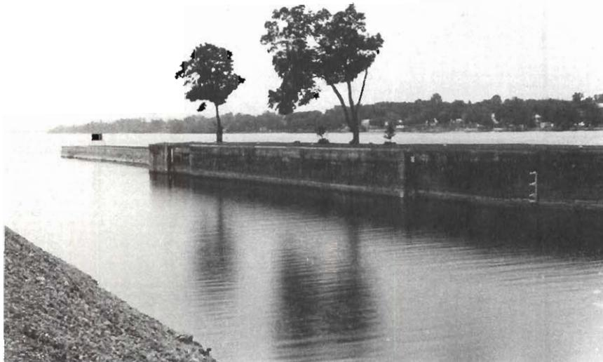
**Figure 15** Le bajoyer (mur latéral) sud de l'écluse n° 1 du second canal Carillon a été préservé de la démolition lors de la construction de l'écluse actuelle de Carillon. Ce mur fait présentement partie intégrante de l'extrémité de la jetée aval qui conduit à l'écluse actuelle de Carillon.
