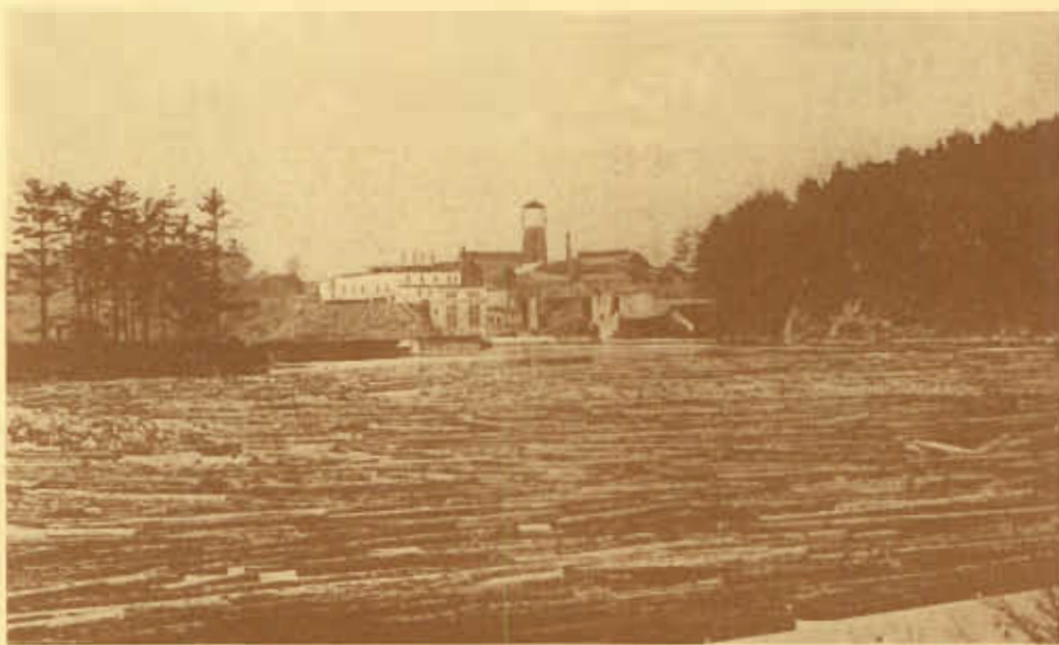
117 — BUCKINGHAM: usines de l'Electric Reduction Co., avec la centrale qui fournit l'électricité à la ville.
