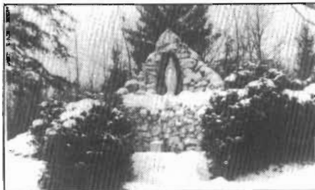
Grotte de Lourdes construite en 1950
