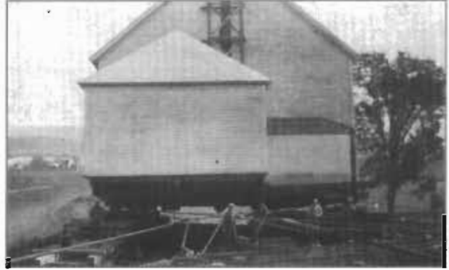
Déménagement de l'Église
