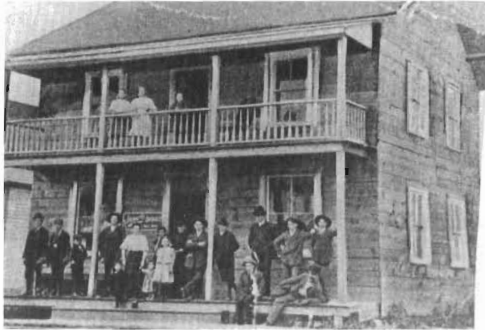
Résidence Latour située à côté de la salle municipale. Elle fut incendiée en 1966.
