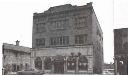
8- Poste de transformation de la Compagnie Hull Electric (76 Promenade du Portage)
