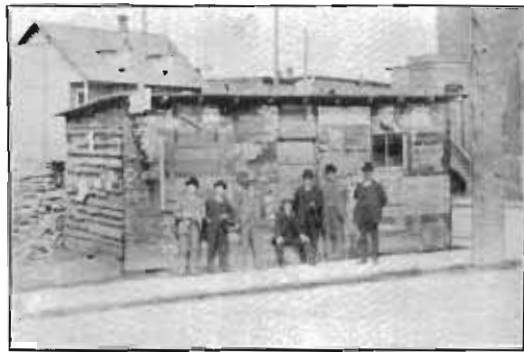
Une des premières cabanes construites après la conflagration de 1900, par M. Joseph Mossette, autrefois de Hull
