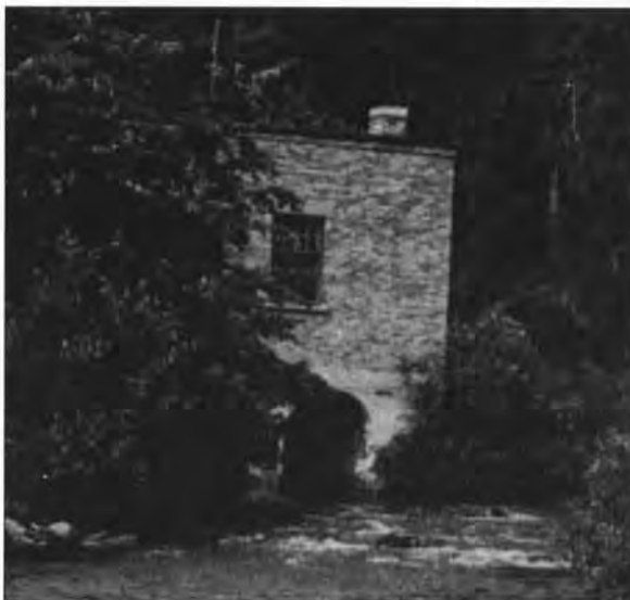
Le barrage de la Petite High Falls Hogue, Clarence et al, Québec : un siècle d'électricité , Montréal, Libre Expression, 1979, p. 202.
