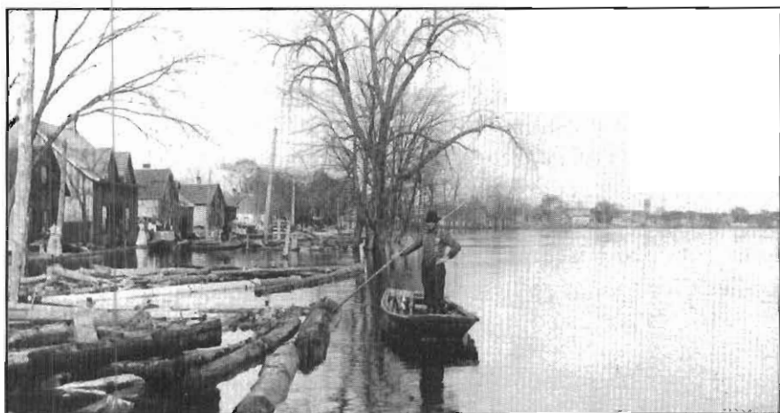
Inondation, rue St-Jean-Baptiste, vue de l'est
