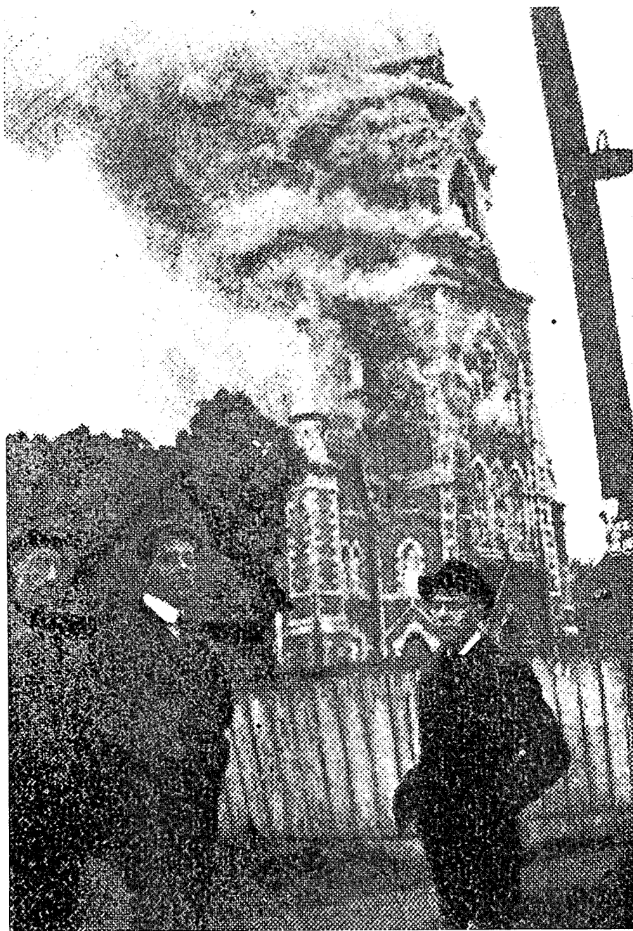
Incendie de l'église Saint-Paul d'Aylmer en 1904.
