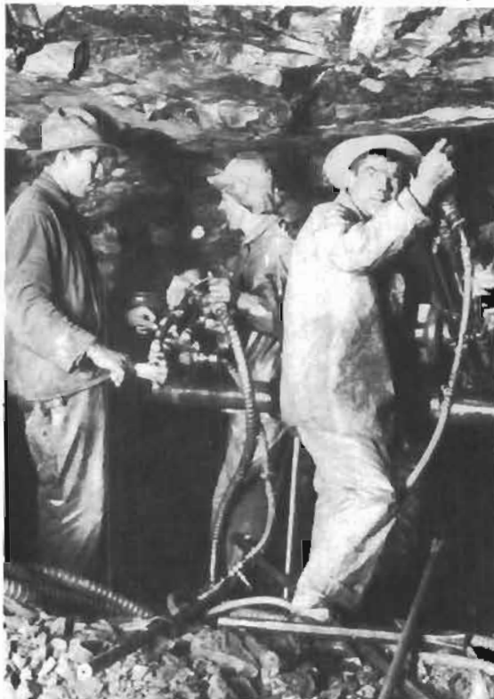
Des employés s'acharnent à couper dans le roc. Les perforatrices qu'ils utilisent fonctionnent à air comprimé. Les débris de roc sont transportés à l'extérieur au moyen de petites locomotives à essence.
