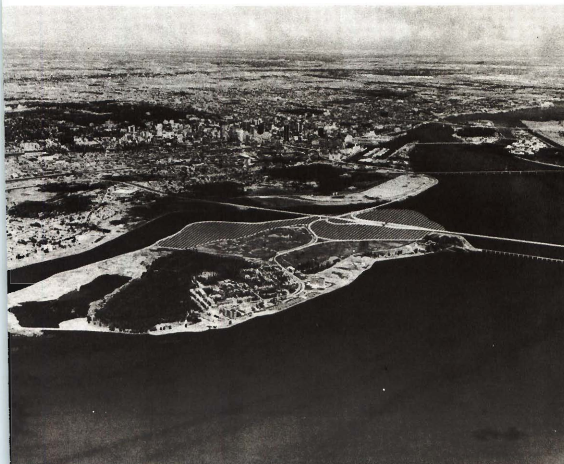
Après la construction de la 1ère phase. Fouilles archéologiques sur la ferme des Le Ber, près du pont Champlain, juin-septembre 1969.
