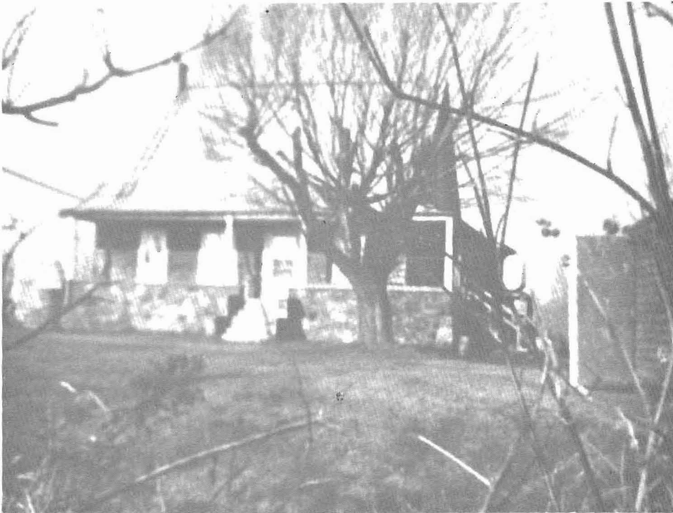
La Montée Saint-Jean compte jusqu'en 1964 nombre de maisons centenaires. Construites transversalement au chemin ces nombreuses propriétés si typiques disparurent afin de permettre l'accès à la Trans-Canadienne. La maison ancestrale des familles Chaurest et Laniel subsiste!
