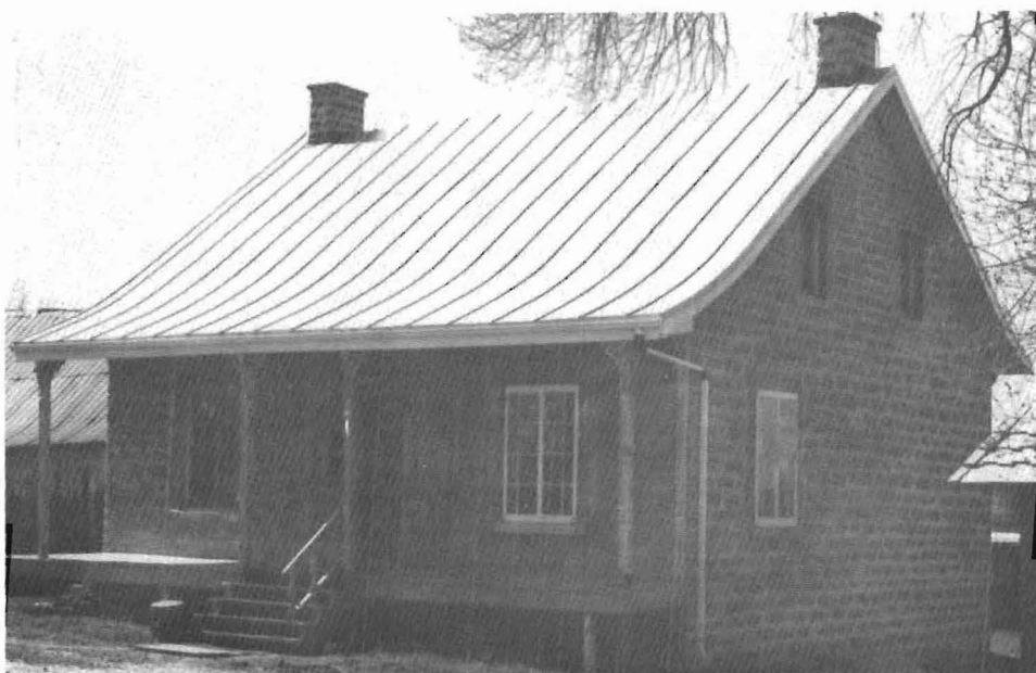
La maison Chauret située au 4398 boul. des Sources date de 1856. Récemment on s'appliquait à redonner à cette maison son charme d'antan, d'ailleurs fort bien réussi . . .
