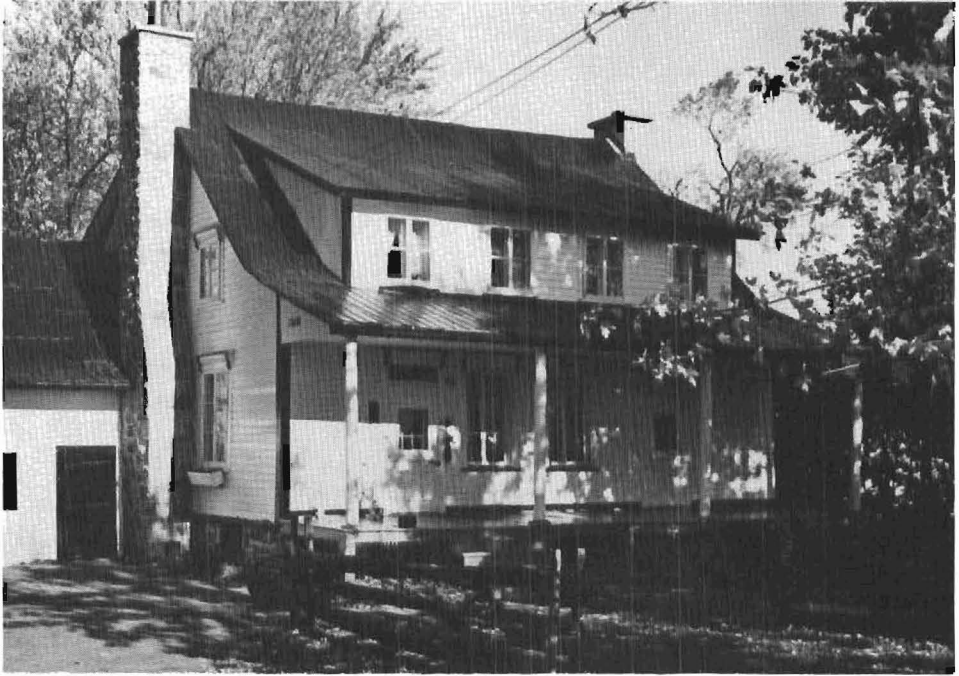
Le 14945 ouest, boul. Gouin. Selon les données de la Municipalité de Sainte-Geneviève, cette maison date de 1804. Une clôture de perches et des ormes magnifiques agrémentent cette propriété.
