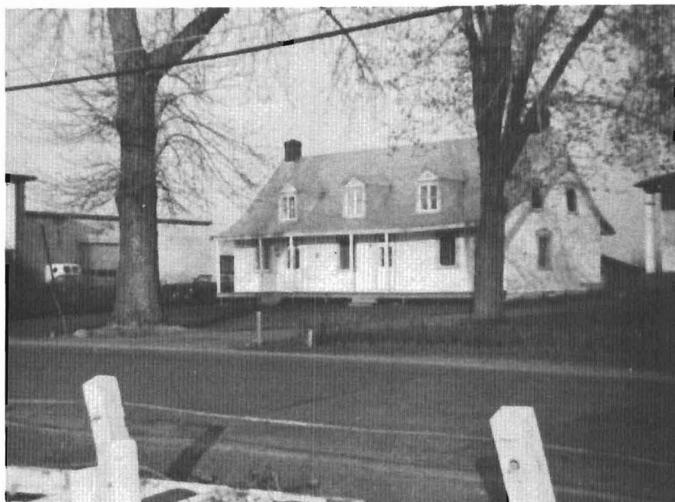
Le 14780-14786 ouest, boul. Gouin. D'après les registres de la communauté urbaine de Montréal cette maison date de 1806. Depuis 8 générations, des familles Théorêt l'habitent. Maison de pièces bloquées de chaux. Les lambris extérieurs datent d'une soixantaine d'années.
