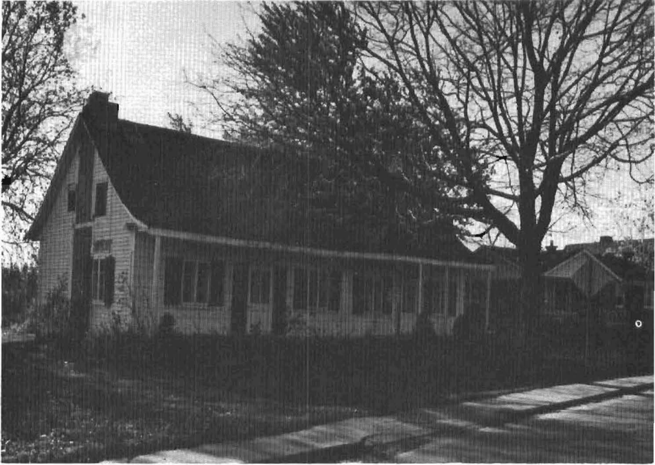
Le 15156 ouest, boul. Gouin. Une partie de cette maison date de 1837. Délaissée depuis un certain temps, elle profite, heureusement, de quelques améliorations l'assurant ainsi d'un meilleur sort.
