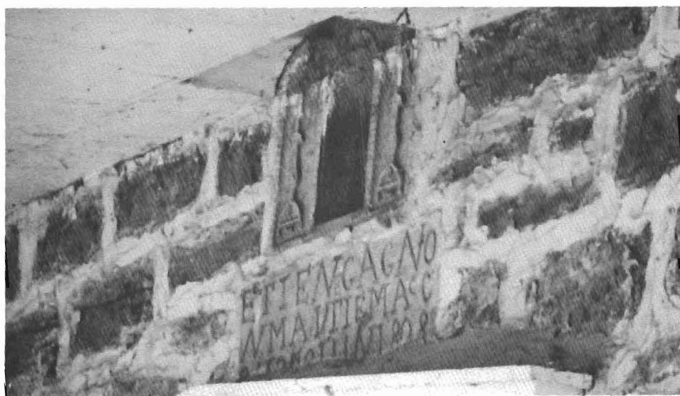
Le 21285 ouest, boul. Gouin construit en 1808. Une pierre gravée du nom d'Etienne Gagnon, maître-maçon, en indique la date. Cette maison est habitée depuis le début par la famille Pilon dont huit générations se sont succédées. Maison située à l'extrémité ouest du territoire originel de la paroisse près de l'Anse à l'Orme.
