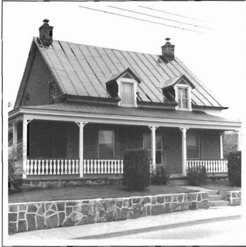
La maison Charles-Gervais Décary est à l'heure actuelle occupée par le petit-fils de ce dernier. Elle aurait été construite à l'époque du cadastre (cf. chap. VIII). Elle faisait partie du village initial de Dorval, à l'intérieur de l'ancien domaine de la Présentation.
