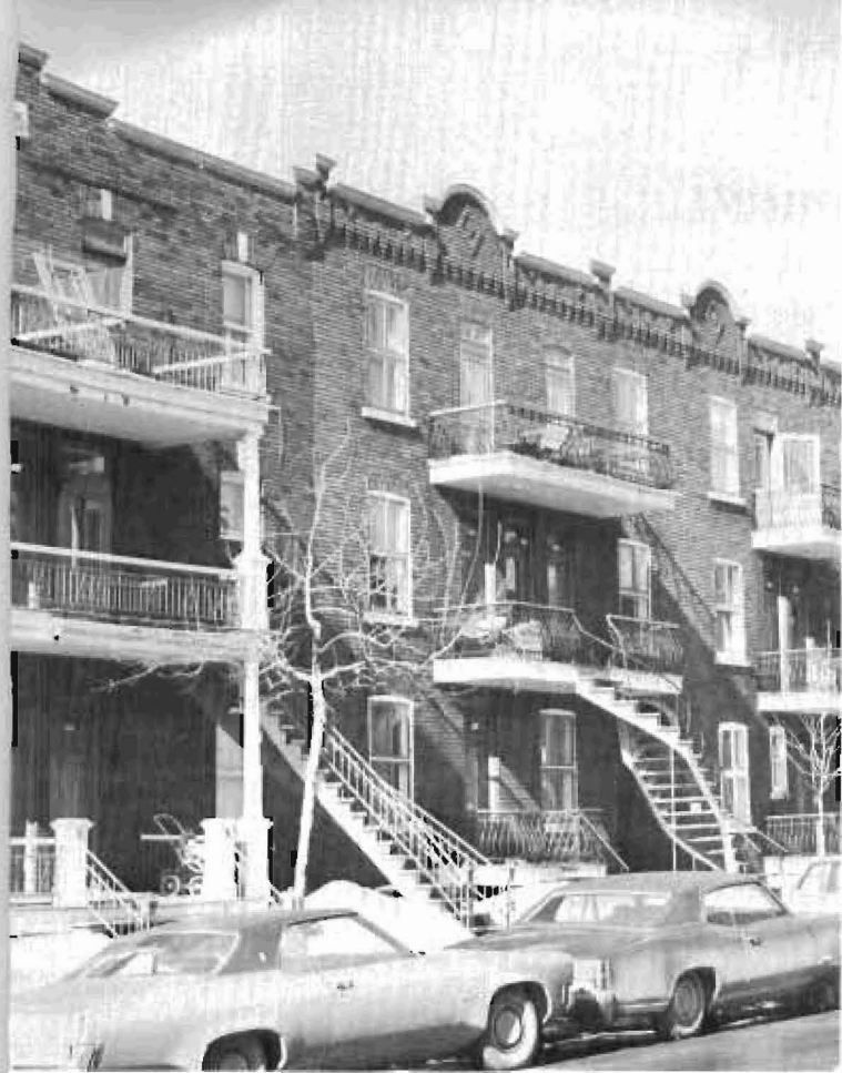
La coopérative d'habitation du village Côte-des-Neiges
