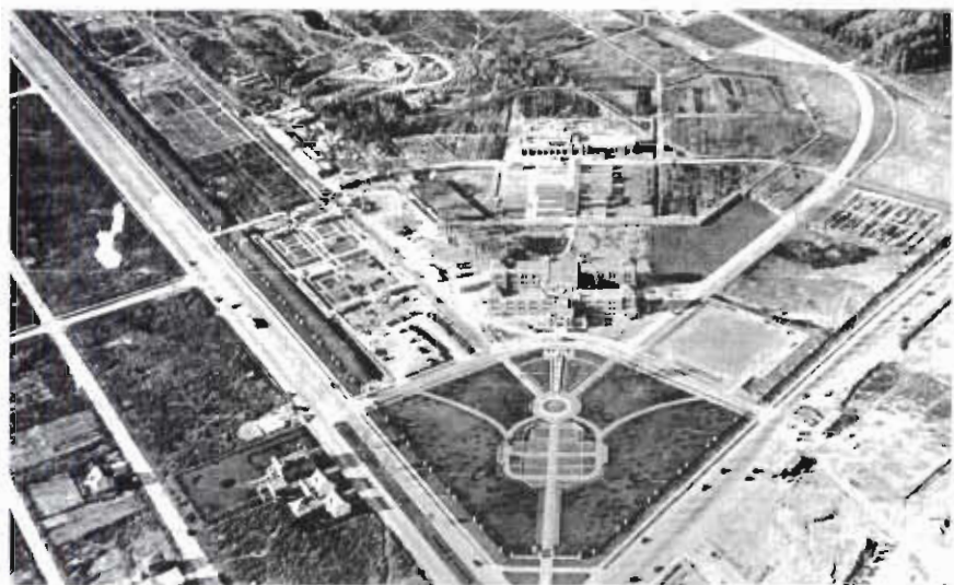
Vue à vol d'oiseau des travaux d'aménagement et de construction au Jardin botanique de Montréal
