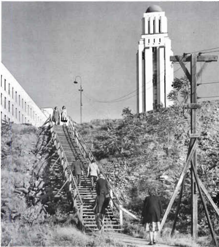
Le lundi 26 avril 1965, les rampes mobiles de l'Université de Montréal, aménagées le long d'un tunnel creusé dans le roc, fonctionnent enfin. Leur vitesse est de 38 mètres à la minute. En une heure, 16 000 personnes peuvent faire l'ascension de la montagne. «Le dispositif, écrit Le Devoir du 27 avril 1965, remplace le vieil escalier de bois à multiples paliers qui servait de gymnase aux étudiants essoufflés.»
