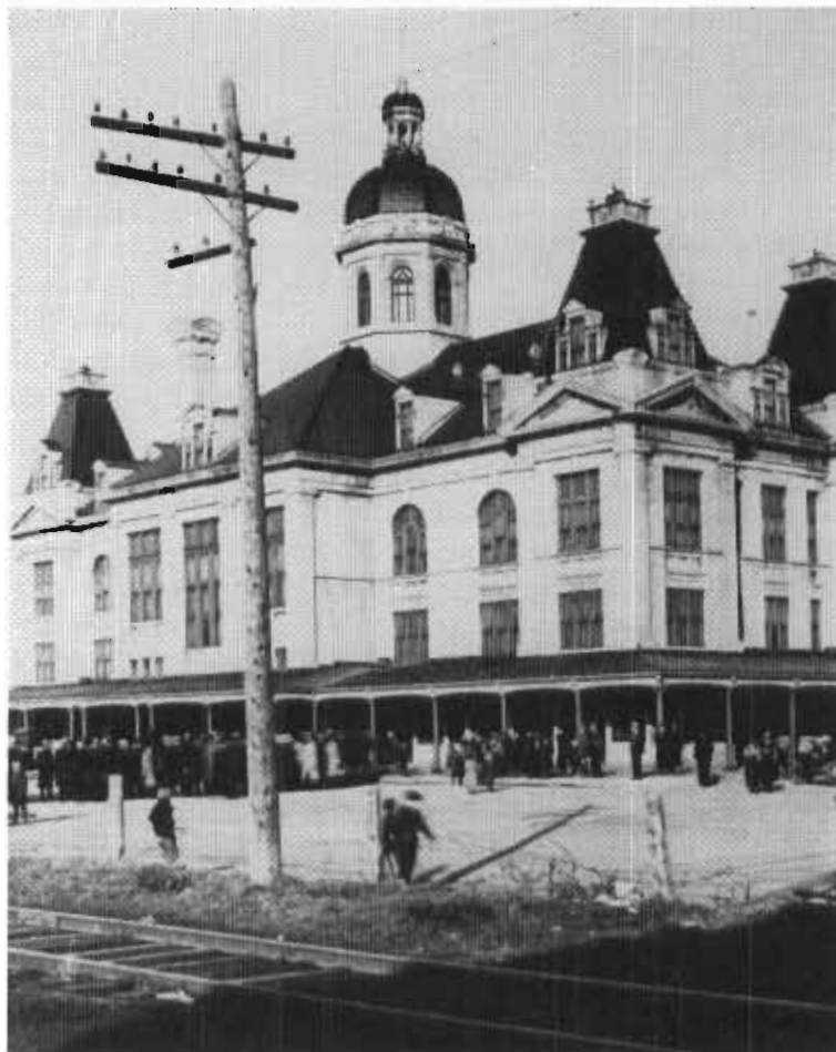
Arrière du marché Maisonneuve photographié en 1930. Il fut inauguré en 1914 et est le seul édifice de la ville de Maisonneuve dont les quatre murs extérieurs sont en pierre grise, ce qui permettait de donner une belle image de Maisonneuve aux gens qui voyageaient en train. Source: Archives de la ville de Montréal.
