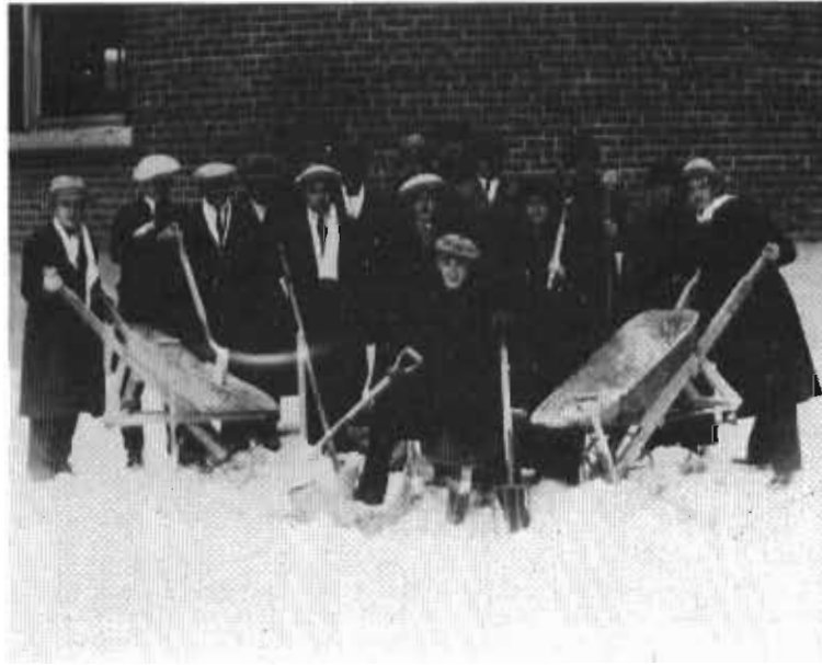
Les jeunes de la Saint-Vincent-de-Paul travaillent à creuser le sous-sol du baptistère en 1931. Source: M. Armand Tessier.
