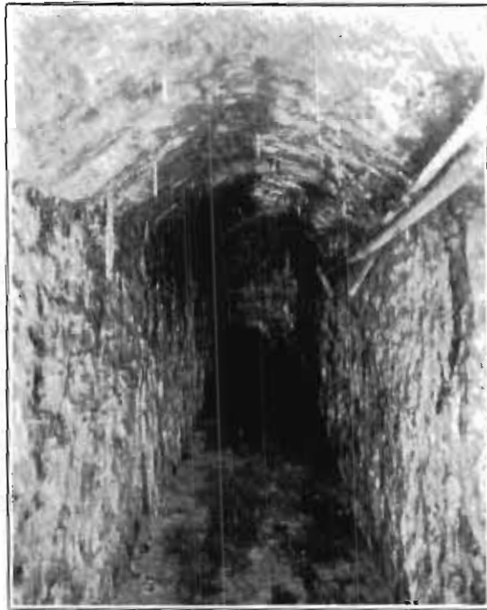
Petit passage souterrain sous la façade du séminaire
