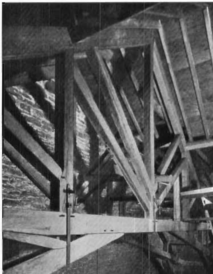
Les poutres de la toiture au-dessus du portique
