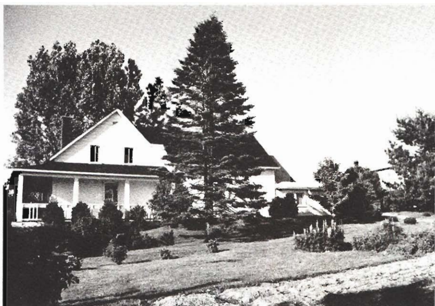
Les bâtiments de la ferme d'aujourd'hui
