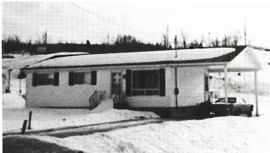
Fin de la construction de la maison, 1972
