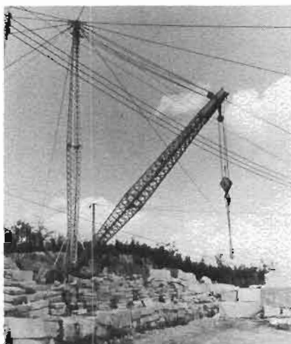
Grue mécanique sur l'emplacement de la carrière
