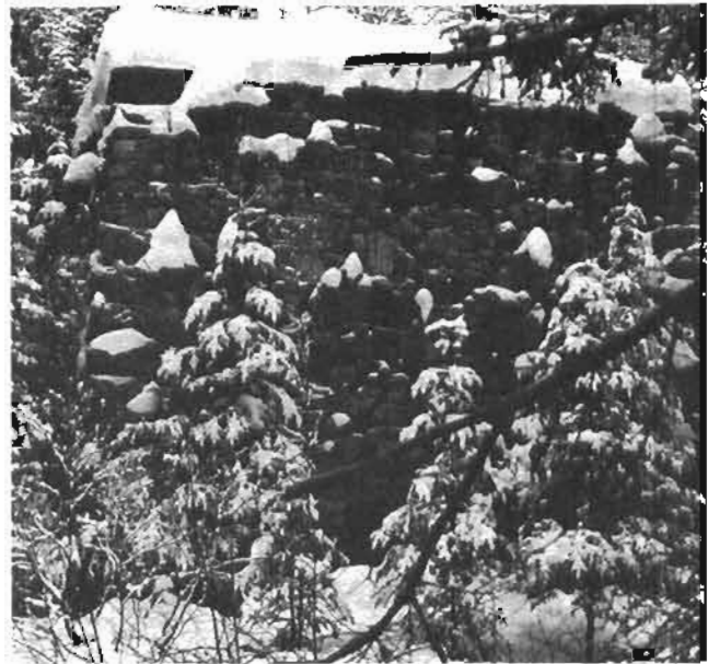
Fourneau à chaux
